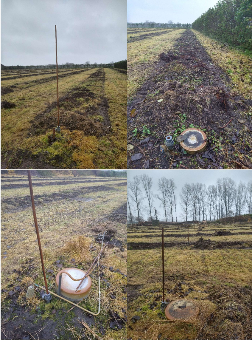
Figuur 6b. Overzichts- en detailfoto's waterleiding. © LARES
