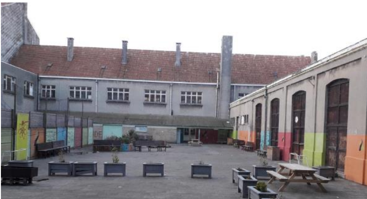
Figuur 10: Zicht vanuit de speelplaats op de achtergevel van 'De Studio' (Bron: Opdrachtgever).
