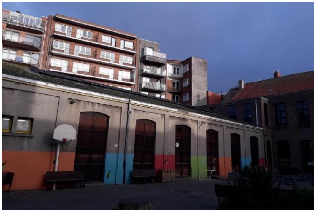
Figuur 11: Zicht vanuit de speelplaats op de turnzaal (Bron: Opdrachtgever).
