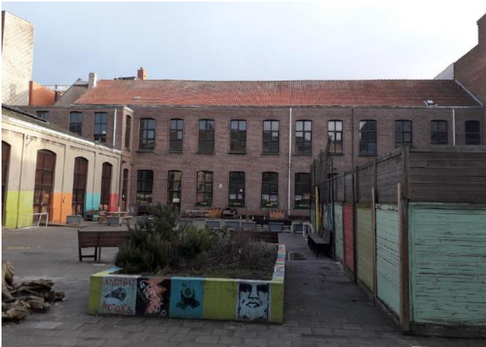
Figuur 9: Zicht vanuit de speelplaats op de achtergevel van het schoolgebouw (Bron: Opdrachtgever).
