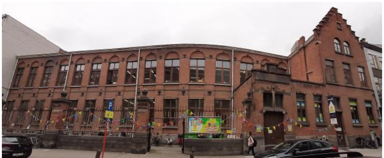
Figuur 8: Voorgevel schoolgebouw vanuit Ieperstraat (Bron: Opdrachtgever).
