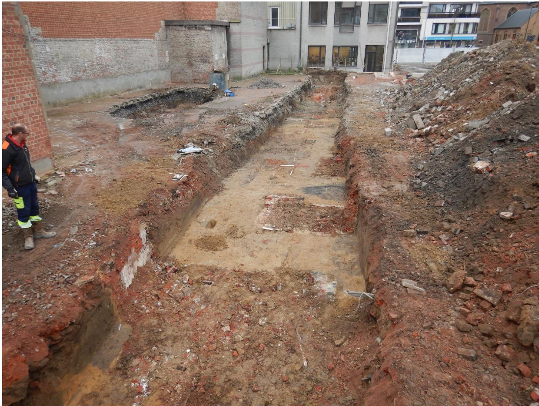
Figuur 38: Zicht op sleuf 6 richting het westen.
