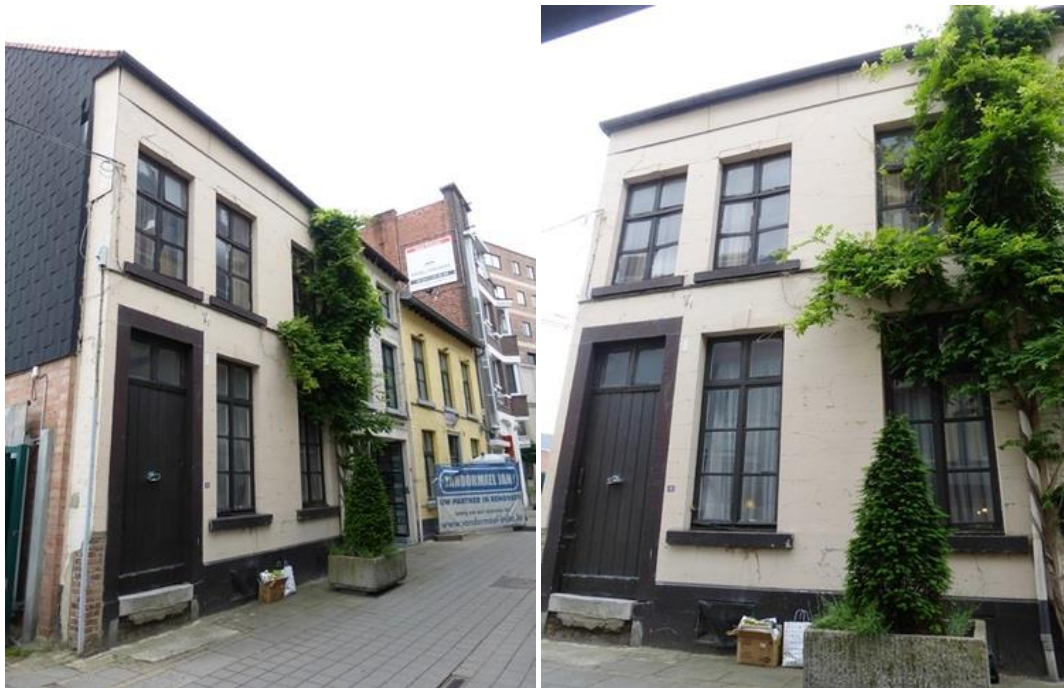
Fig. 8: Voorgevel van woning met huisnummer 12.
