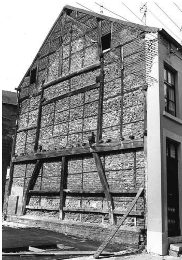
Fig. 1.10: Vakwerk vastgesteld in 1975 (© Inventaris Onroerend Erfgoed).
