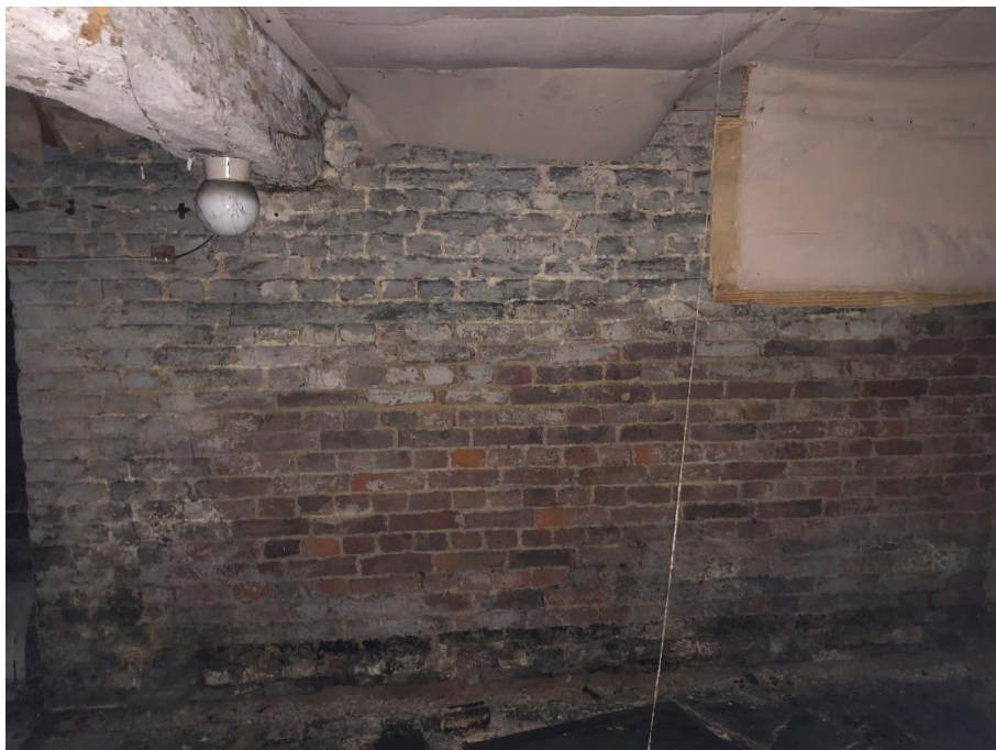
Fig. 1.12: Kelder onder het woonhuis.
