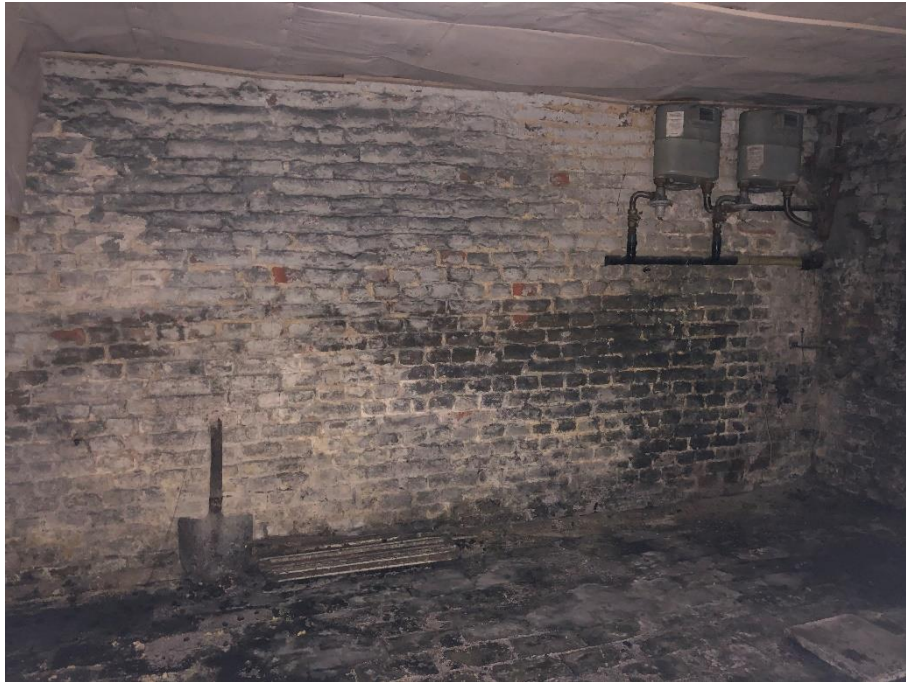
Fig. 1.11: Kelder onder het woonhuis.
