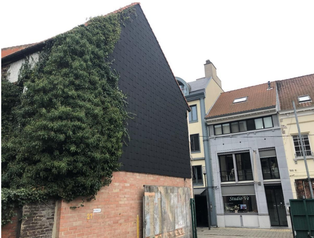
Fig. 1.9: Recente buitenmuur geplaatst voor het vakwerk.
