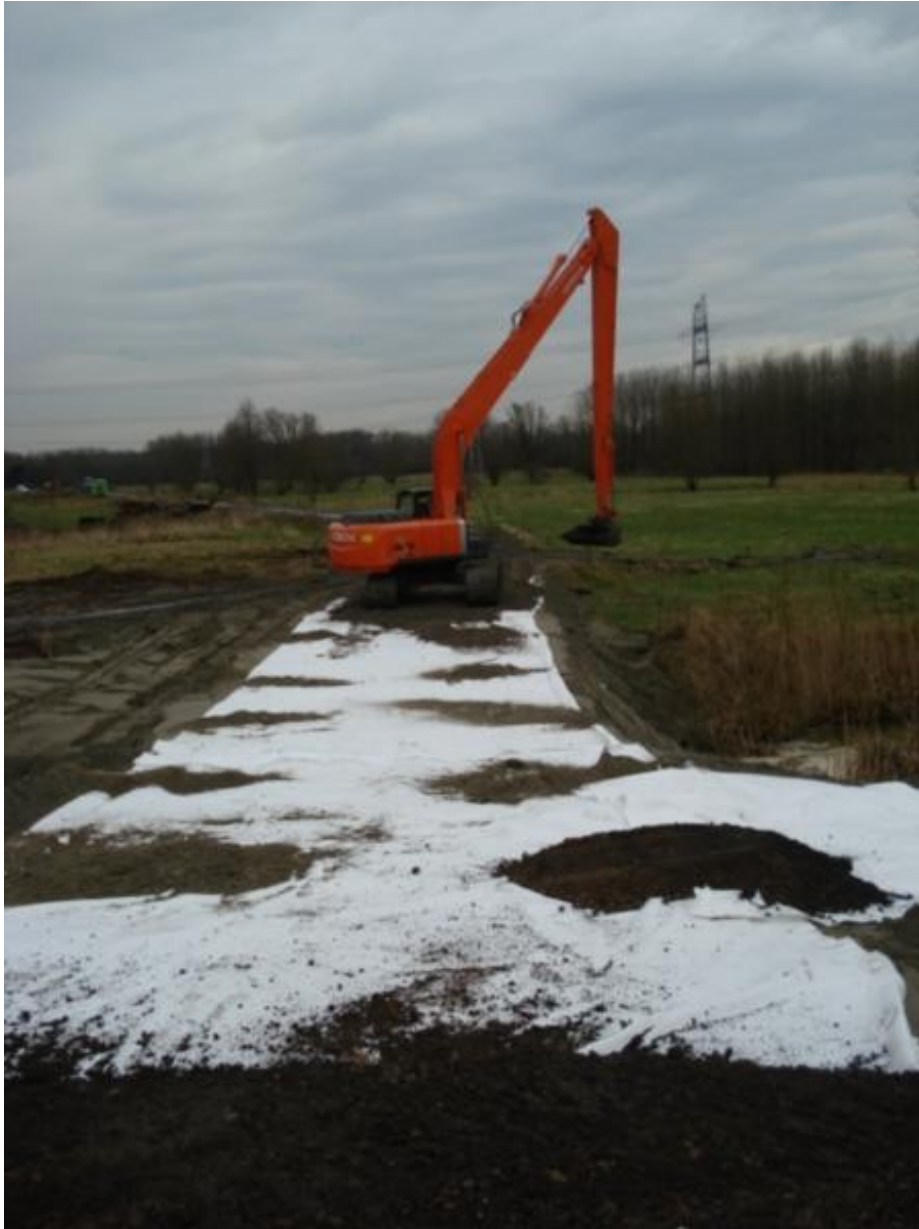
Fig. 6. Afgraven van de akkers voor de flanken van de ringdijk, ter hoogte van de Dijkstraat in Rupelmonde (Marcel Vernimmen, www.waaserfgoed.be ).
