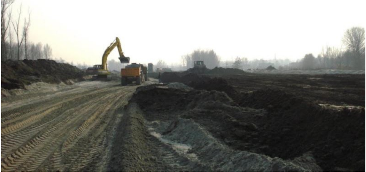
Fig. 4. Foto van de aanleg van de ringdijk (Marcel Vernimmen, www.waaserfgoed.be ).
