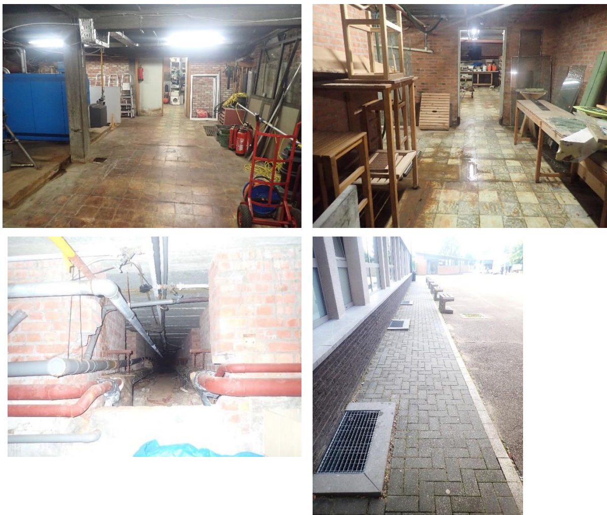
Fig. 15: kelder van gebouw F, kruipkelders en verluchttingsrooters van de (kruip)kelder aan de speelplaatszijde
