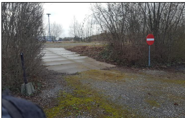
Figuur 20: Zicht op het niveauverschil t.h.v. de parking (ABO nv 2022)
