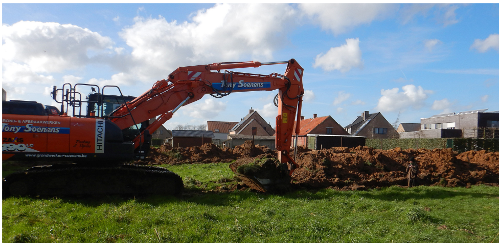
Figuur 6. Algemeen puttenplan. Onder: sfeerbeeld in westelijke richting tijdens het aanleggen van de proefsleuven .
