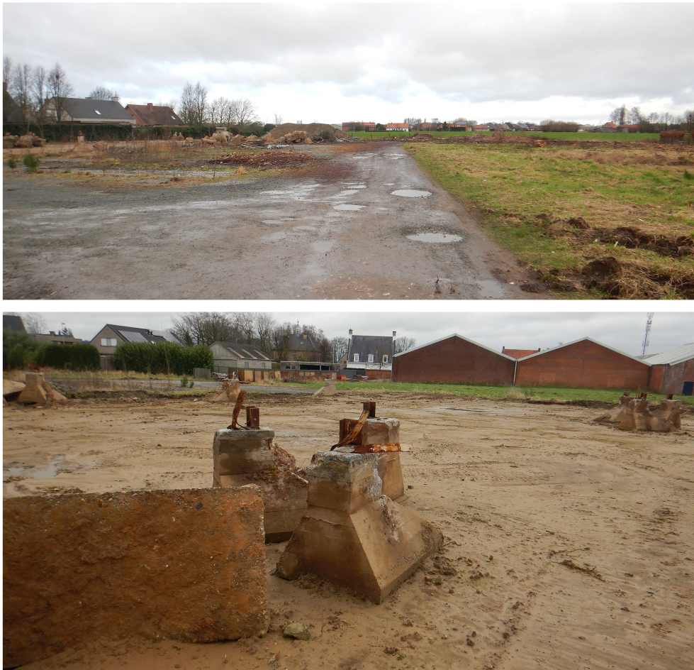
Figuur 1. Zicht op het terrein net na de sloopwerken.
