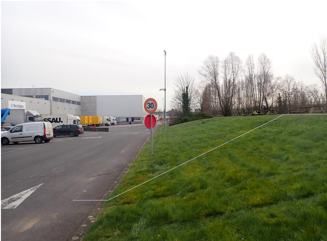
Figuur 17: Zicht op de ophoging binnen de advieszone met ten noorden ervan de huidige parking (© J. Verrijckt)
