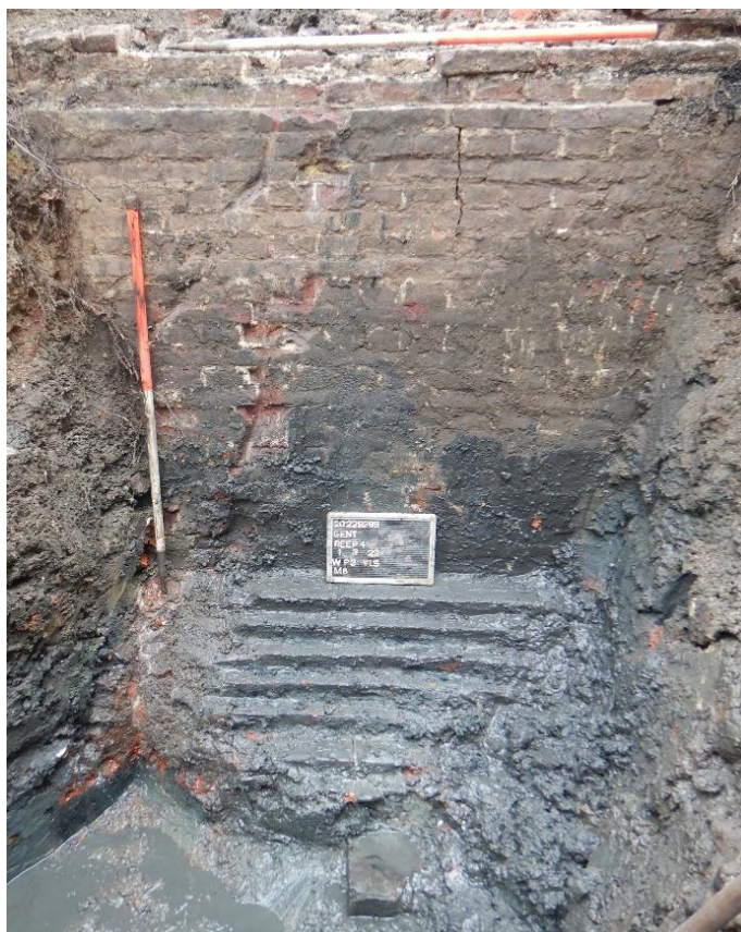
Figuur 39: Werkput 3, zuidoost aanzicht van muur M9 met onderaan houten balk MH01
