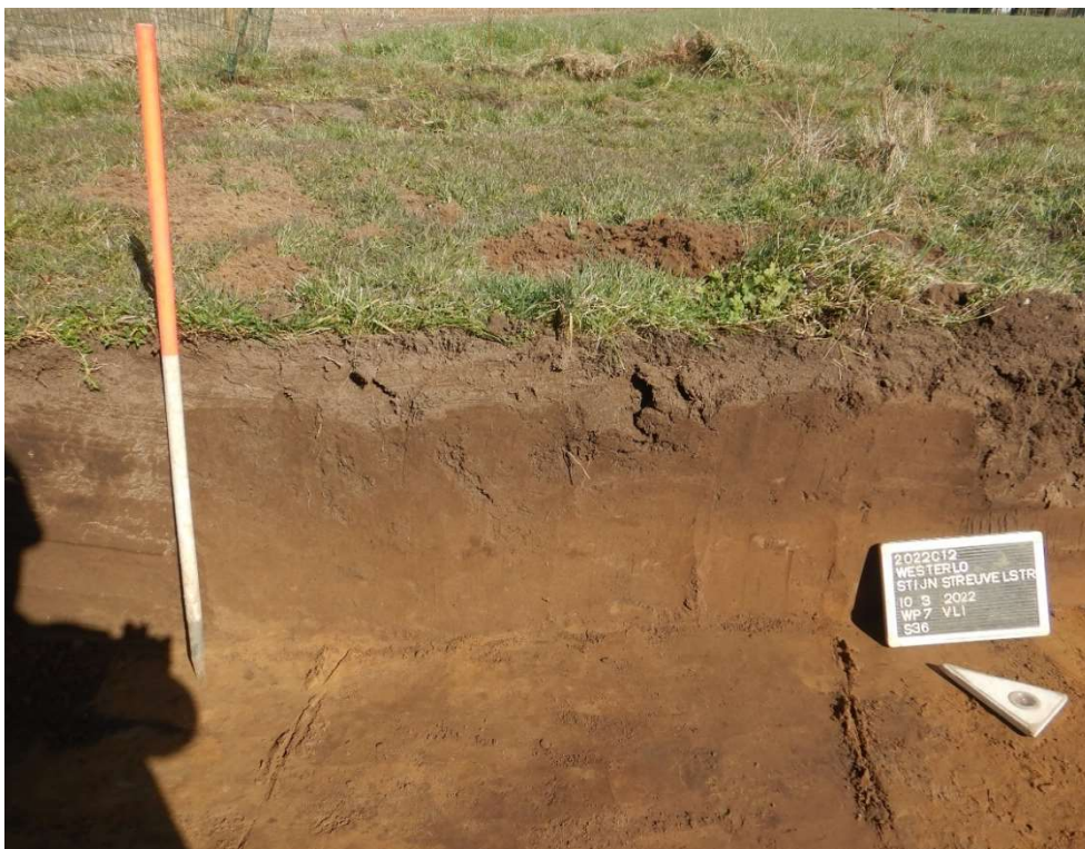
Figuur 29: WP7, greppel S36 in profiel
