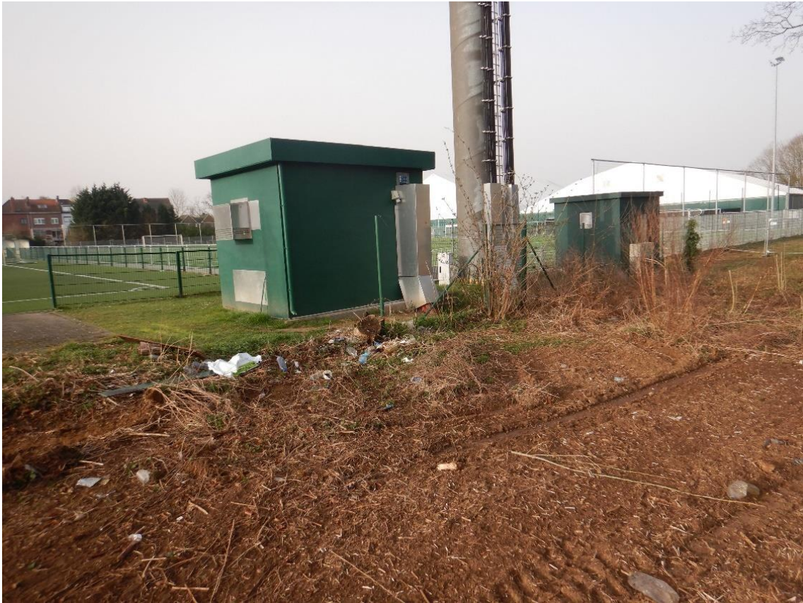
Figuur 6: Werkfoto zendmast en stroomcabines
