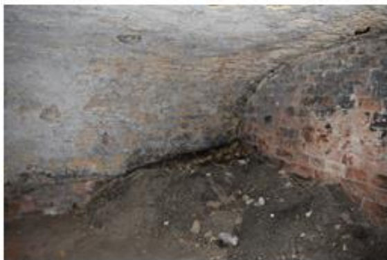
Muur b c
