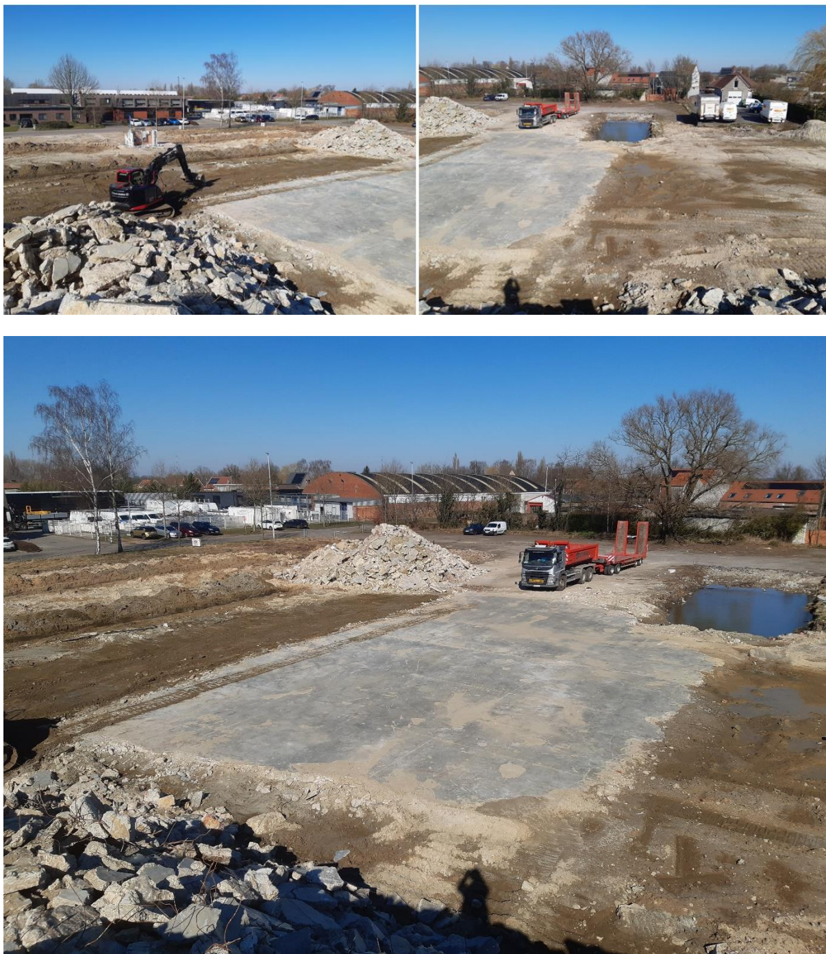
Figuur 26: Enkele foto's van de nog aanwezige betonplaat en de omvangrijke, deels opgevulde uitbraakkuil (© J. Verrijckt bvba).
