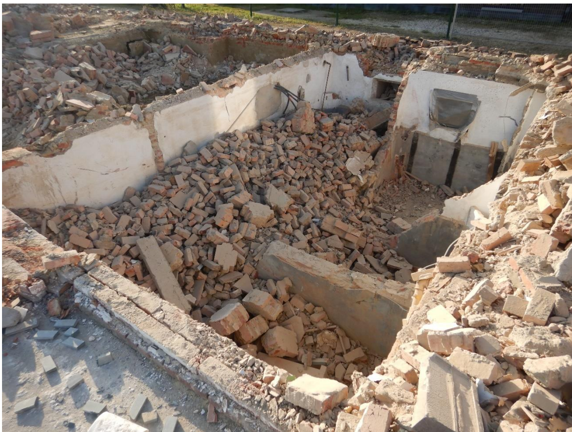
Figuur 8: Kelders onder de woningen aan de straatzijde
