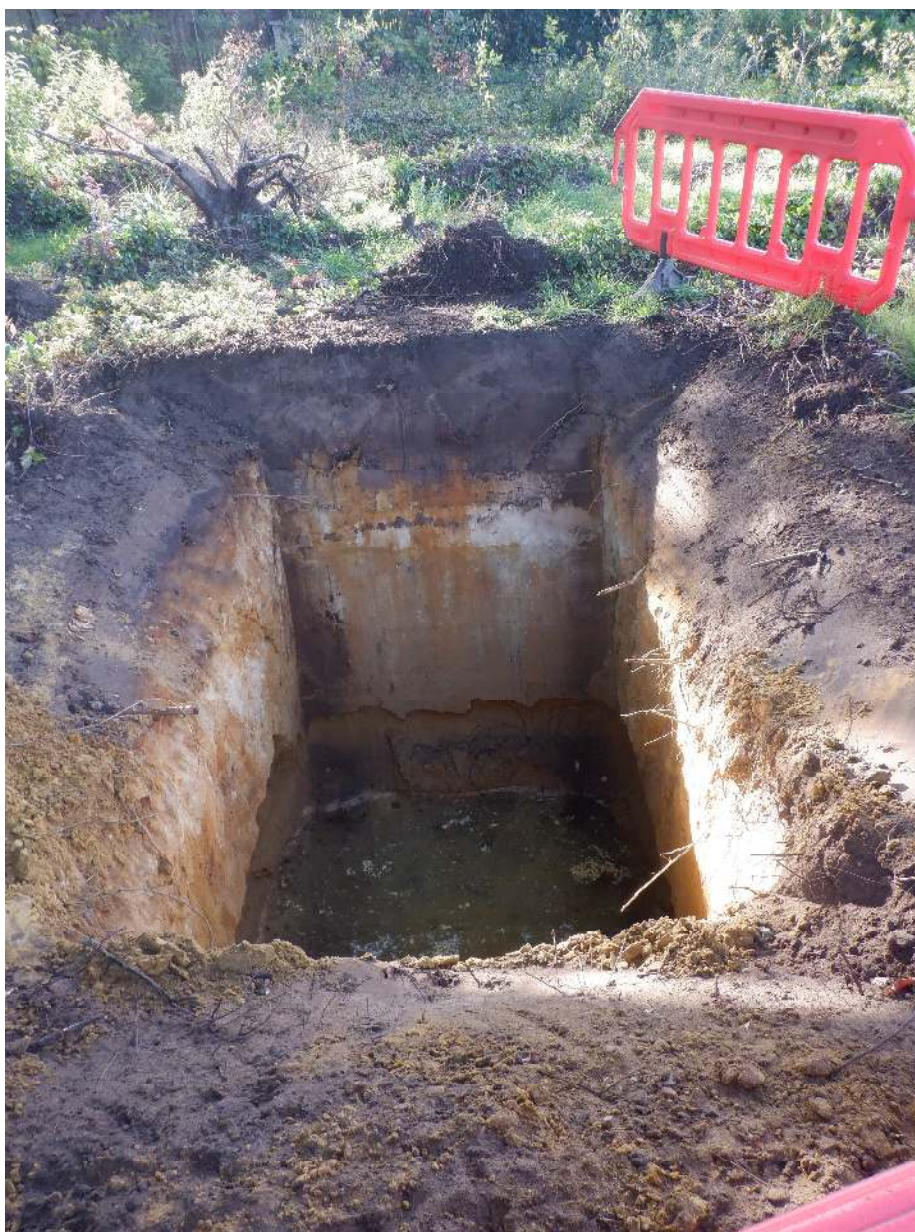
Afbeelding 3.6.2.2: Eén van de drie proefgaten die al gemaakt waren door de aannemer voor de start van het onderzoek.
