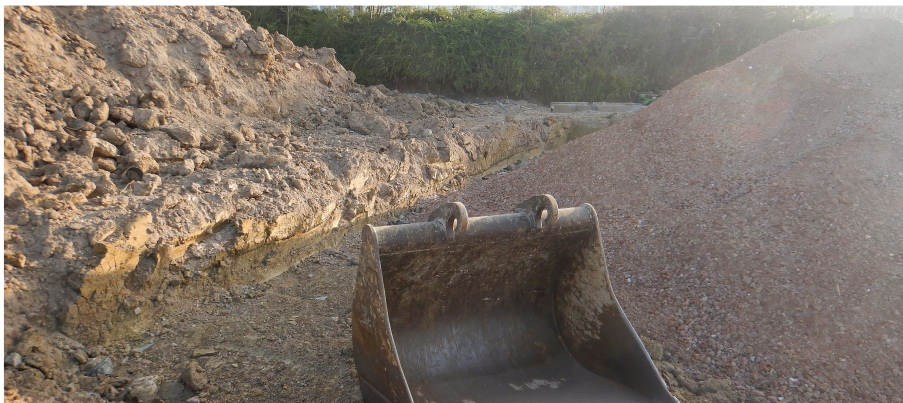
Figuur 4. Boven: de dikke funderingsplaten van 80 centimeter. Onder: de bouwput reikt reeds diep in het tertiair sediment.
