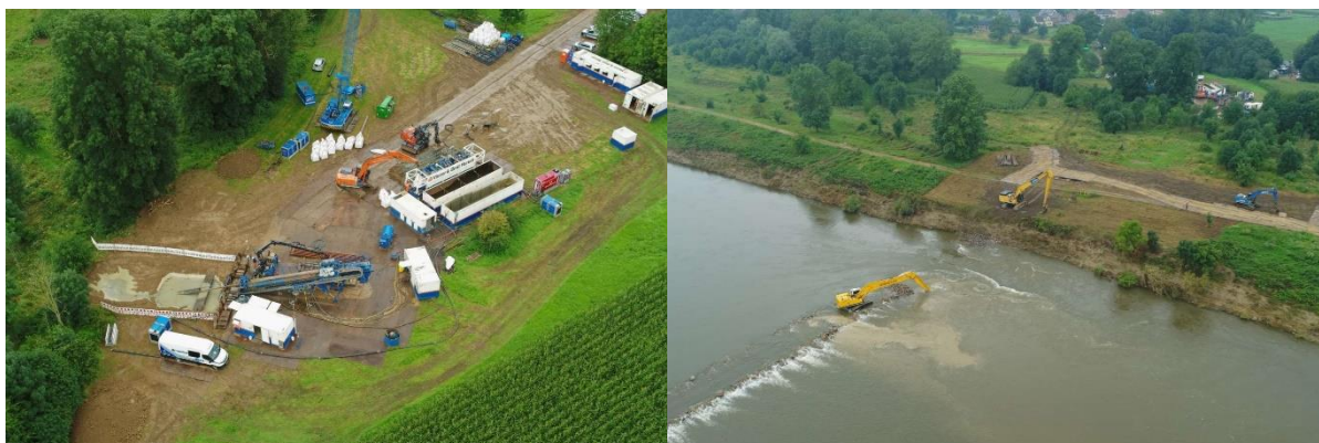
Figuur 9. Links: het plaatsen van de nieuwe leiding met een gestuurde boring, rechts: Kranen werkzaam ter hoogte van de Maas (bron: opdrachtgever).
