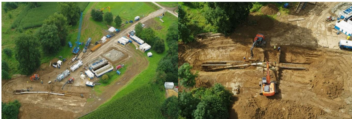
Figuur 7. Links: het plangebied en de werfinrichting, rechts: de oude leiding wordt vrij gegraven en vervangen, (bron: opdrachtgever).
