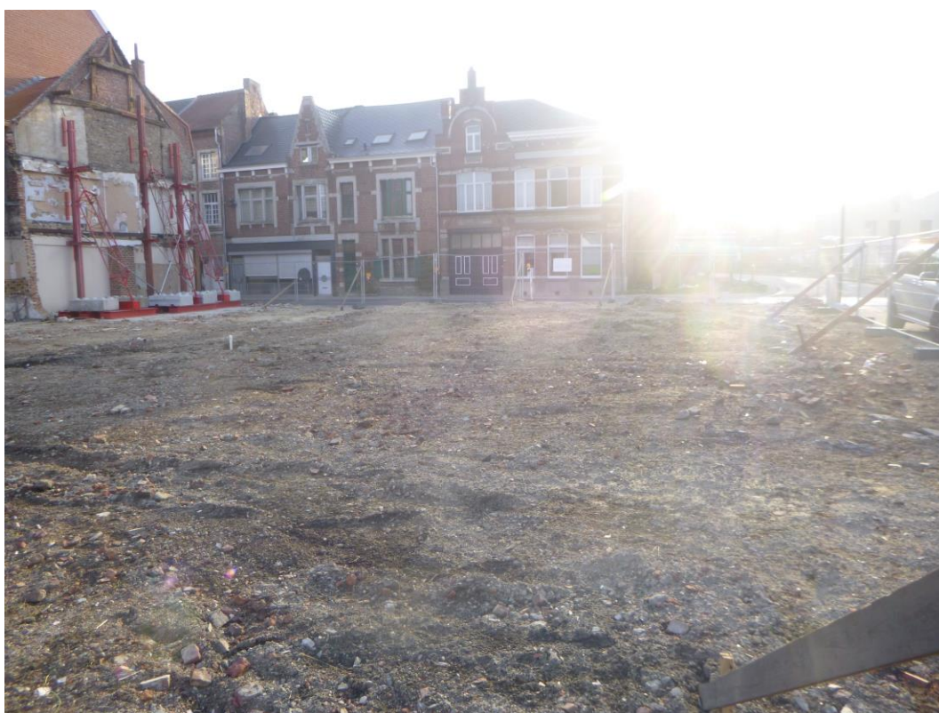
Afb. 2. Zicht op het terrein na de afbraakwerken.
