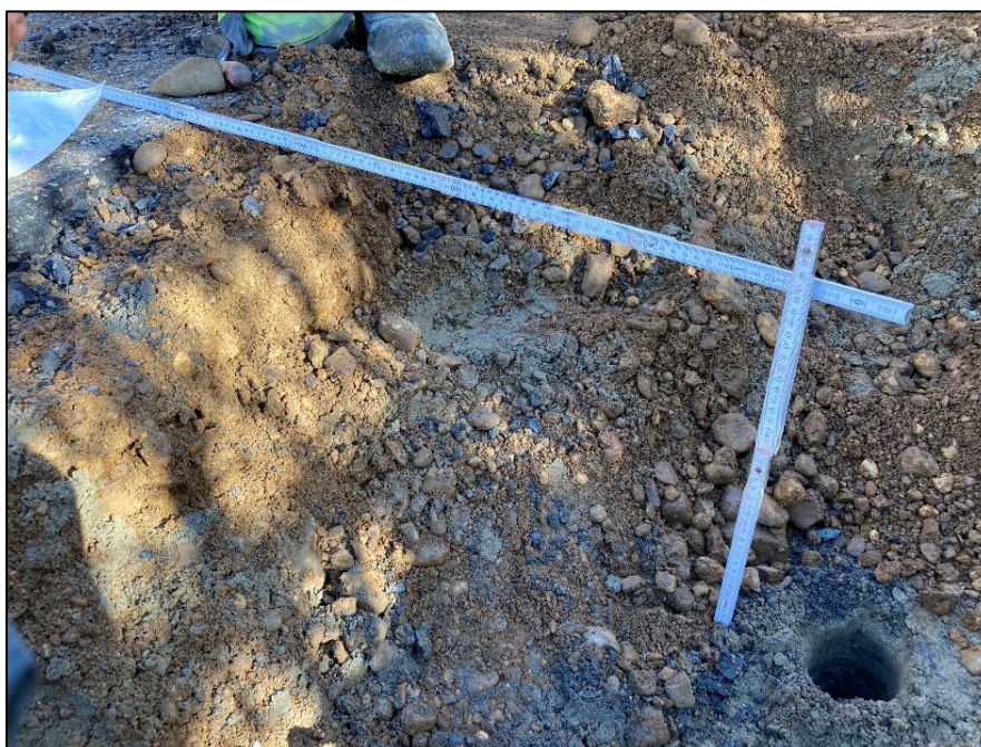
Figuur 13: Machinaal weghalen verharding en onderliggende steenslag thv B13 en aanduiding diepte top zavel
