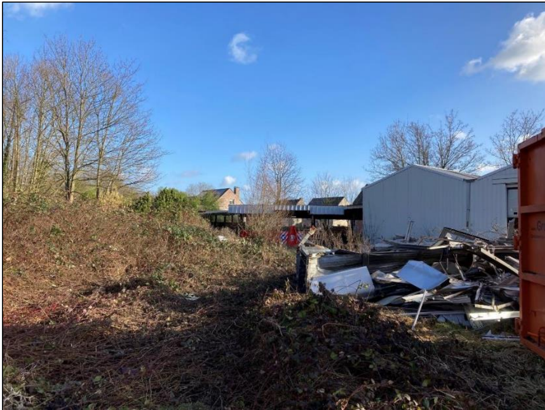
Figuur 33: Zicht richting het noorden vóór de sloop
