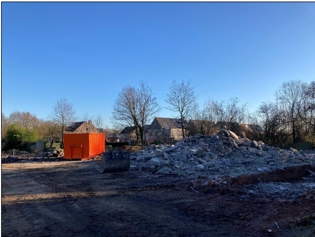
Figuur 34: Zicht richting het noordoosten na de sloop
