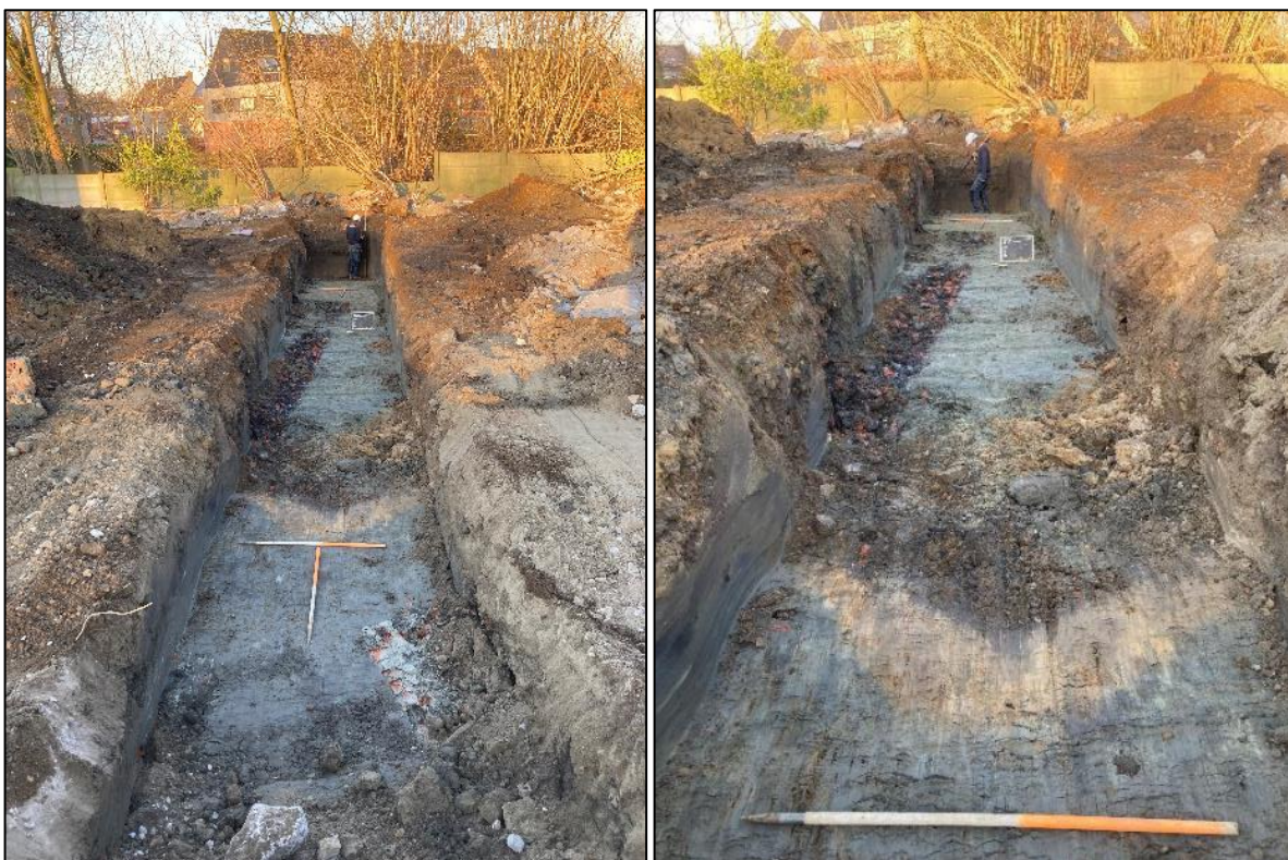
Figuur 53: Zicht op werkput 5 richting het noordoosten en detail van spoor 6 (uitbraakspoor) en recente verstoring, eveneens in vermoedelijk verontreinigde ondergrond
