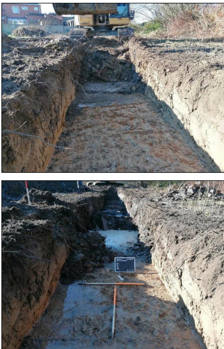
Figuur 45: Zicht op zwaar verstoorde en natte zone in het zuidwesten (als gevolg van hangwater tussen puin)
