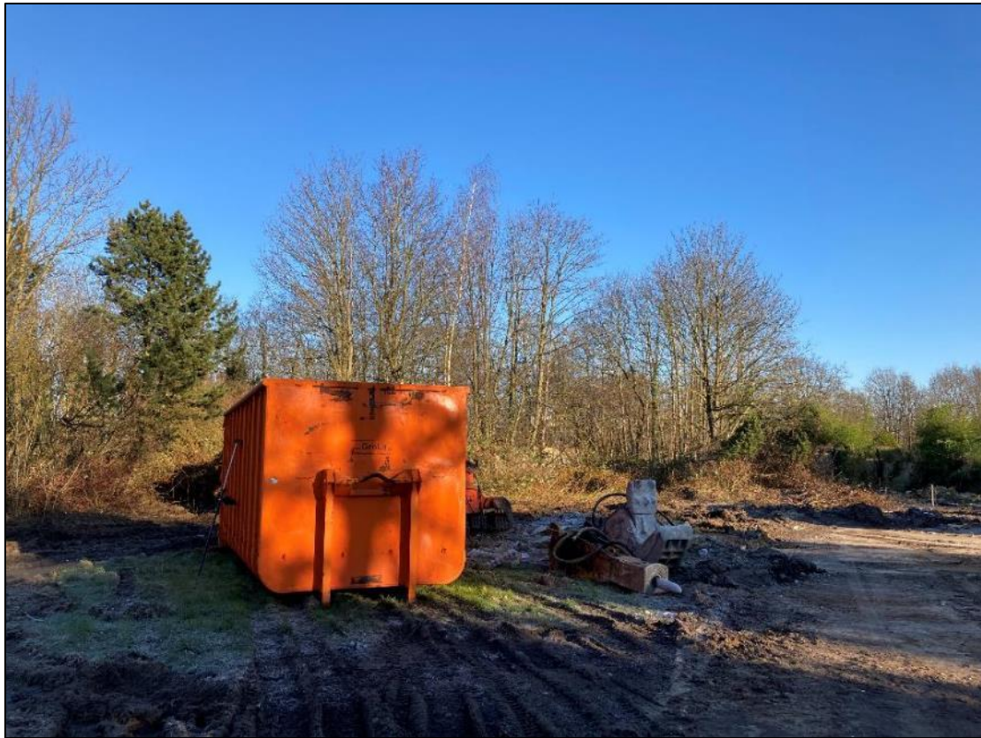
Figuur 35: Zicht richting het noordwesten na de sloop
