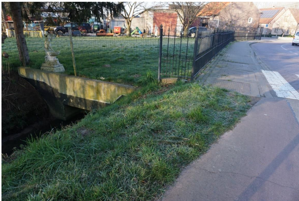
Fig. 2.27: Overzicht Deel 10 met zicht op ingekapselde beek.
