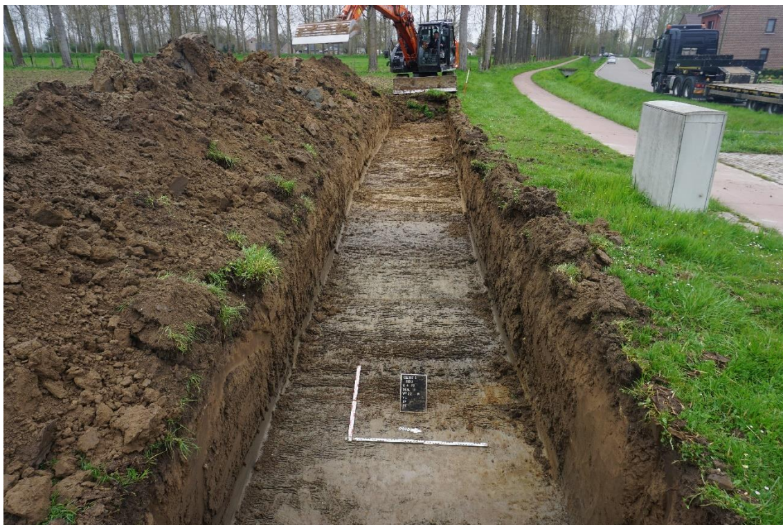
Fig. 2.74: Overzichtsfoto in Proefsleuf 22 (WP22) in Deel 11.
