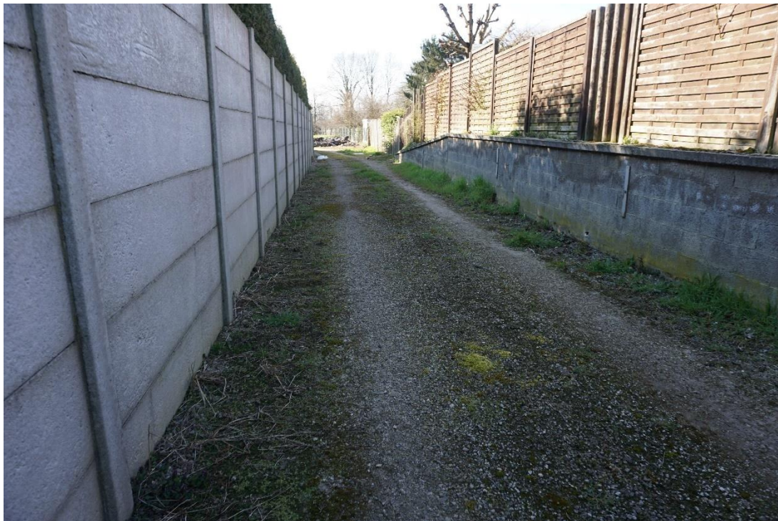
Fig. 2.16: Overzicht Deel 2, toegangsweg in noordelijke richting.
