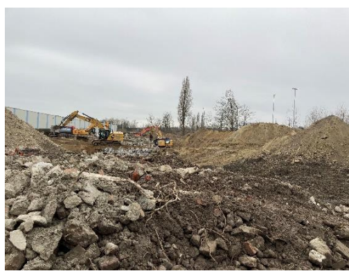
Figuur 5: Foto van de afbraak van de waterinstallatie (Foto opdrachtgever)
