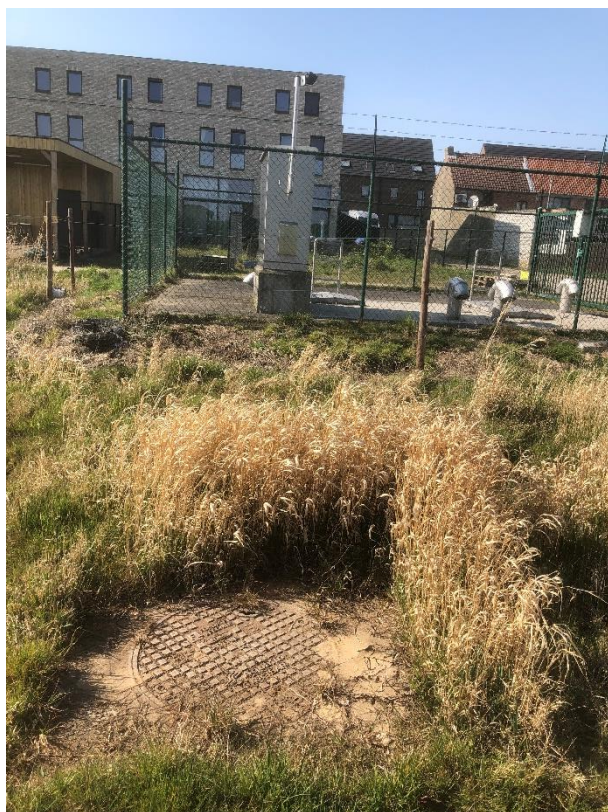
Fig. 2.7: Zicht op putdeksel noordelijk deel..
