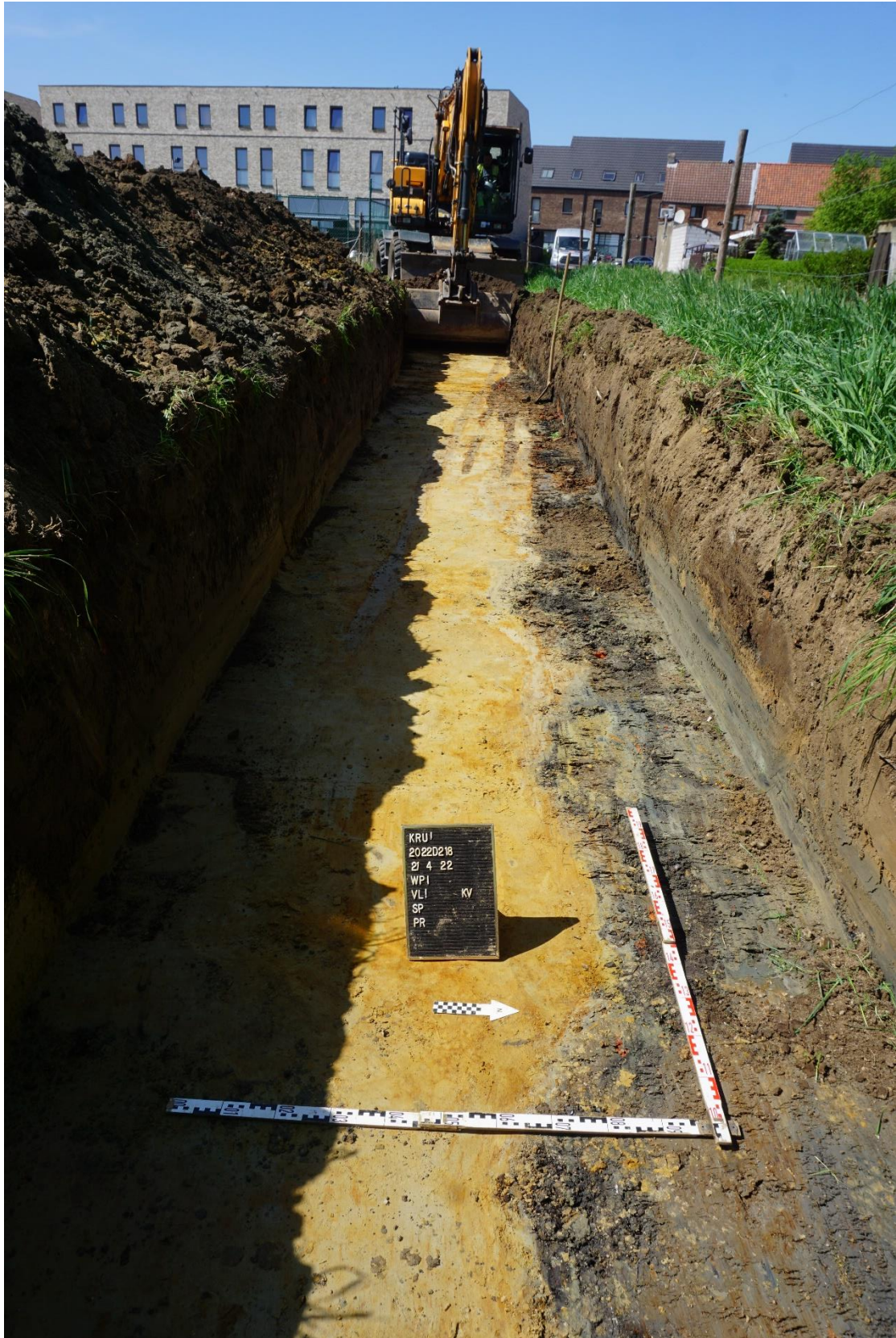
Fig. 3.9: Overzichtsfoto in Proefsleuf 1 (WP1).
