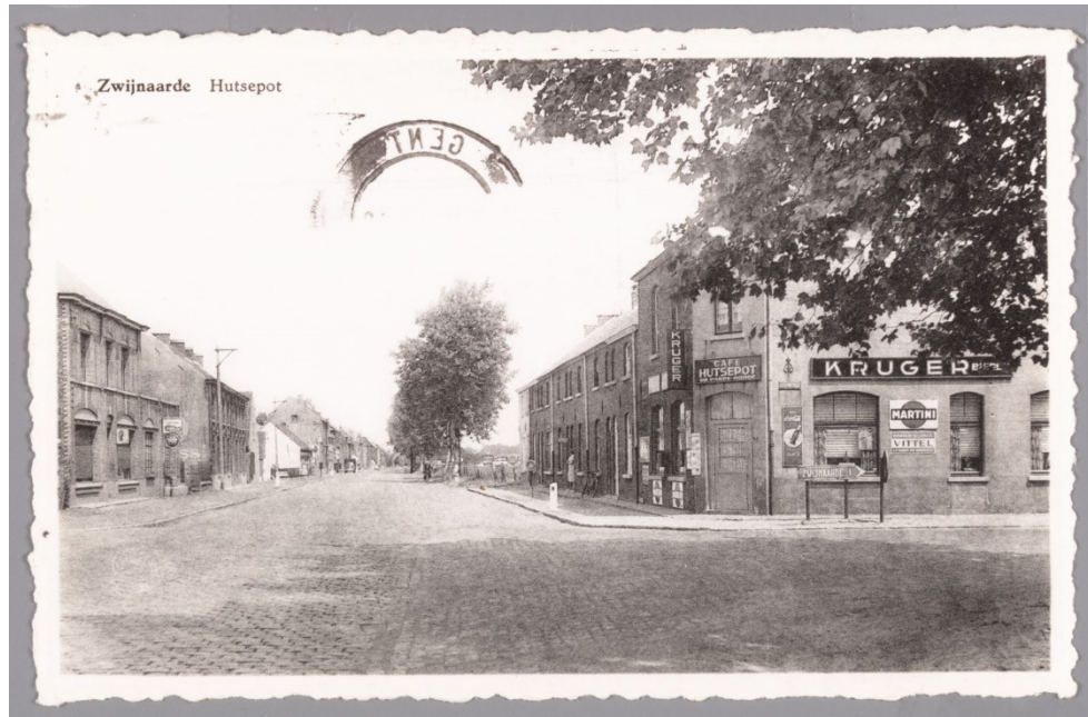
Figuur 33. Het kruispunt van de Hutsepotstraat (rechts) en de Oudenaardsesteenweg met rechts de voormalige herberg 20 .
