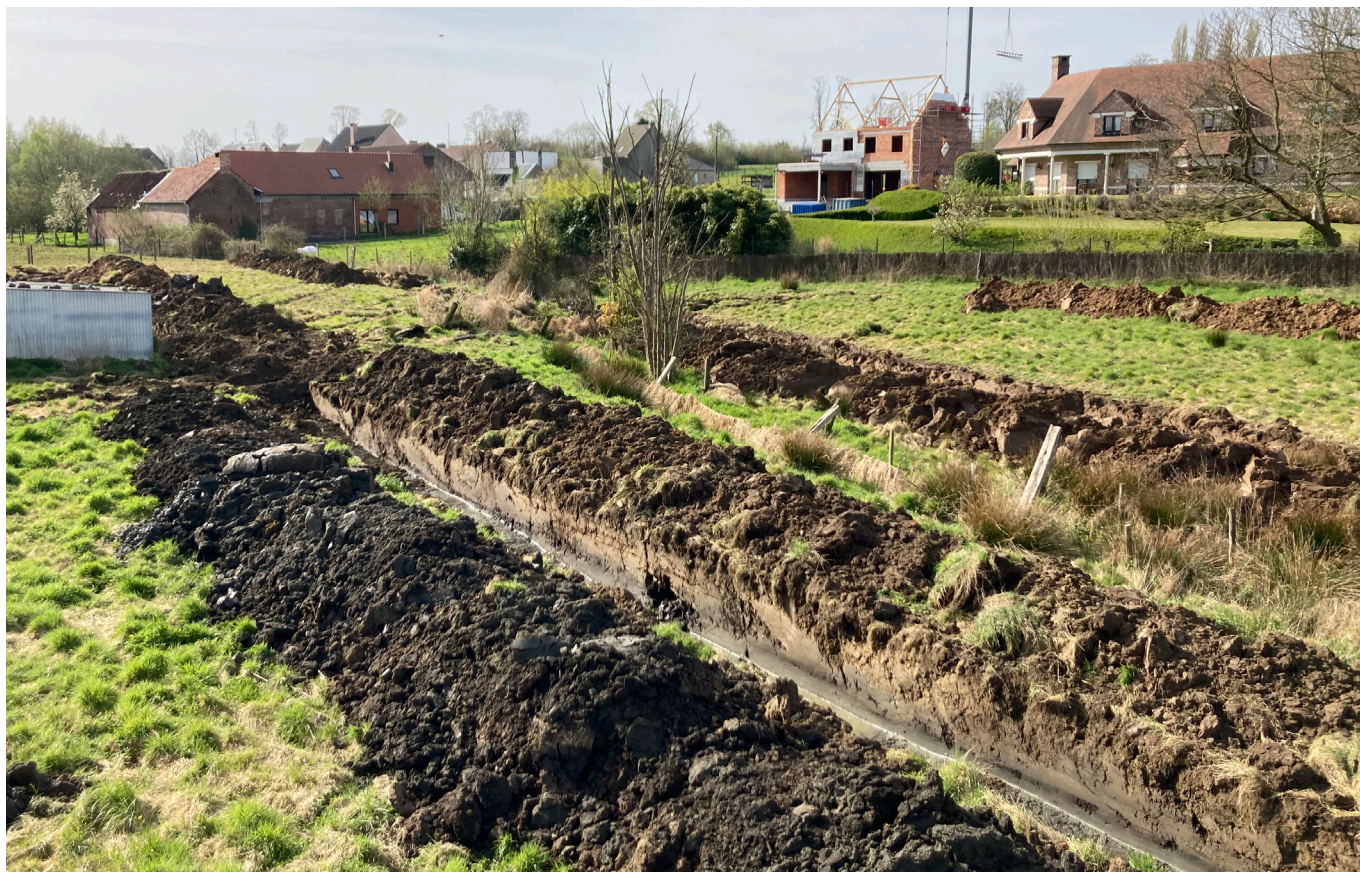
Figuur 18: Zicht op het projectgebied tijdens het onderzoek
