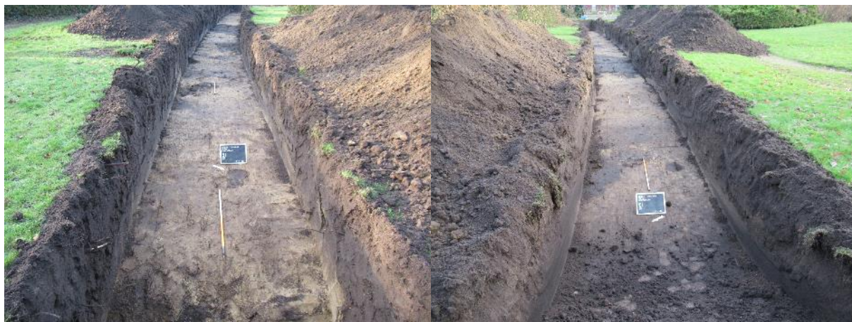
Figuur 17: Overzichtsfoto's werkput 1 (zone Markt) (Bron: ABO nv 2022).
