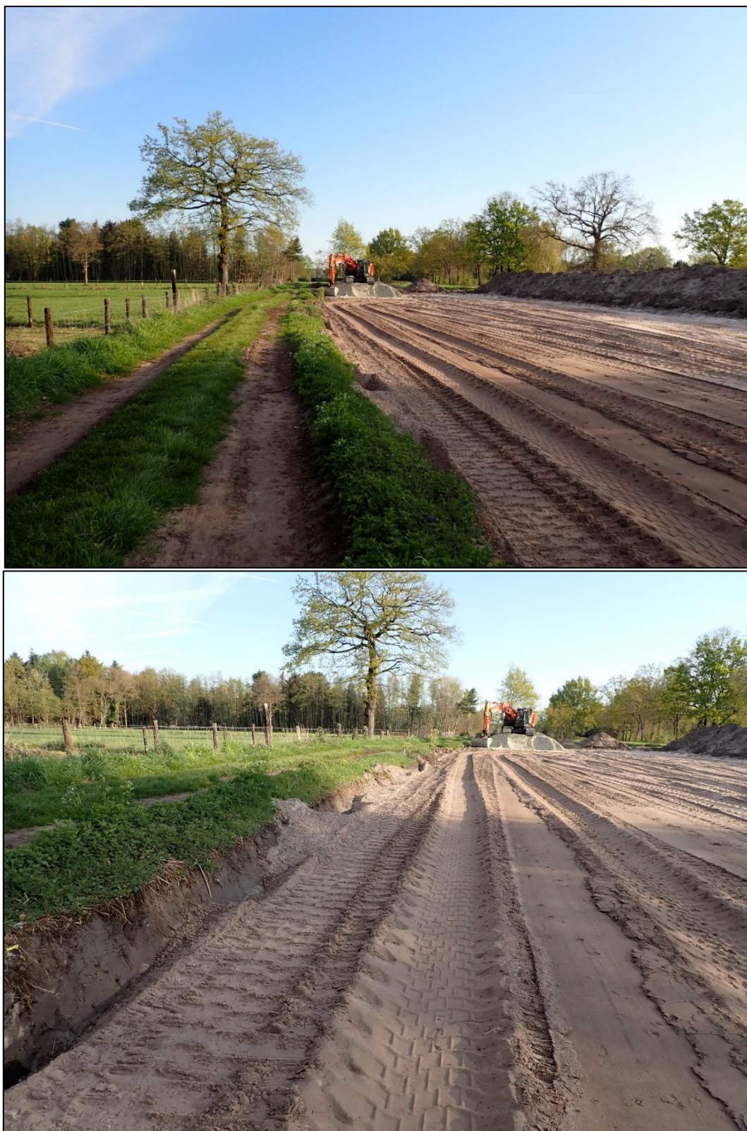
Figuur 7: Zicht op afgraving
