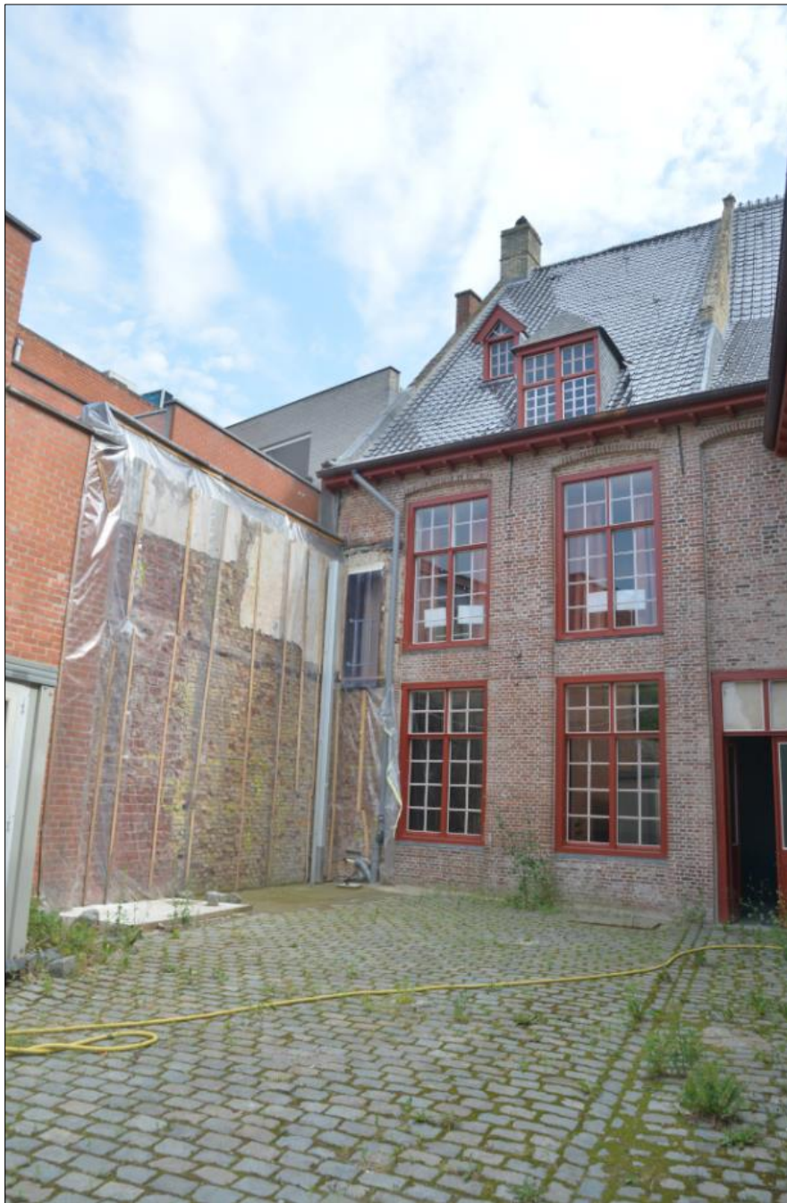
Figuur 5: Zone waar de geplande werken worden voorzien (bron: opdrachtgever).
