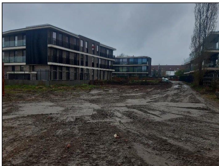
Figuur 4: Zicht op de zone waarin boring 3 meerdere keren oppervlakkig werd gestuit.
