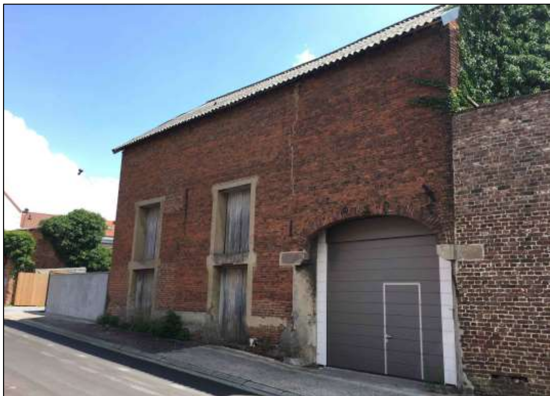
Afb. 7: Zicht op de meest noordelijk gelegen bebouwing, schuur langs de weg Nieuwland zonder nummer. Foto genomen uit het noordwesten (foto initiatiefnemer, datum onbekend).
