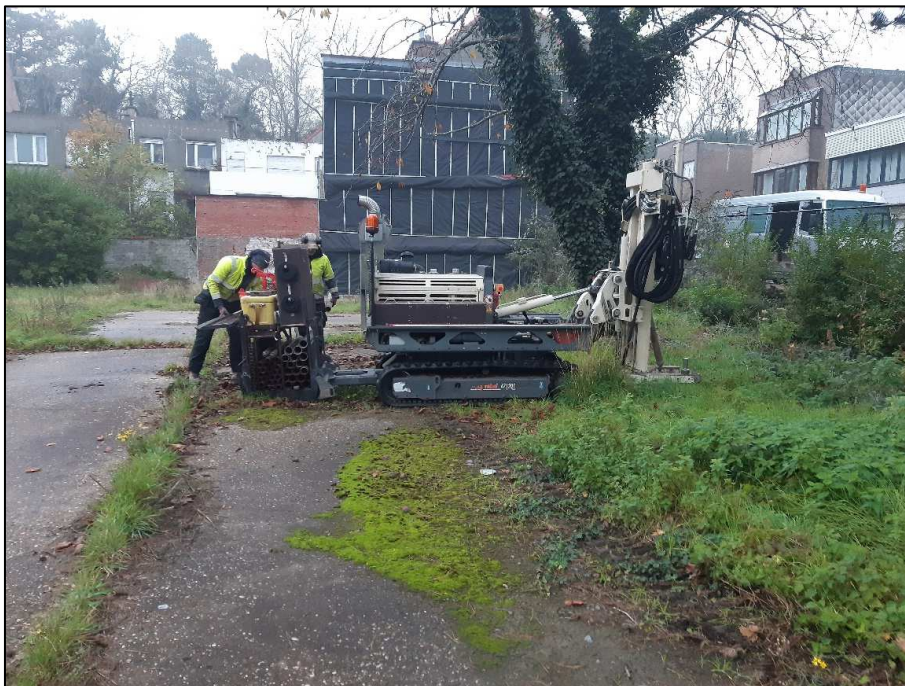
Figuur 6: Zicht op de Geoprobe machine tijdens de uitvoer van boring 5.
