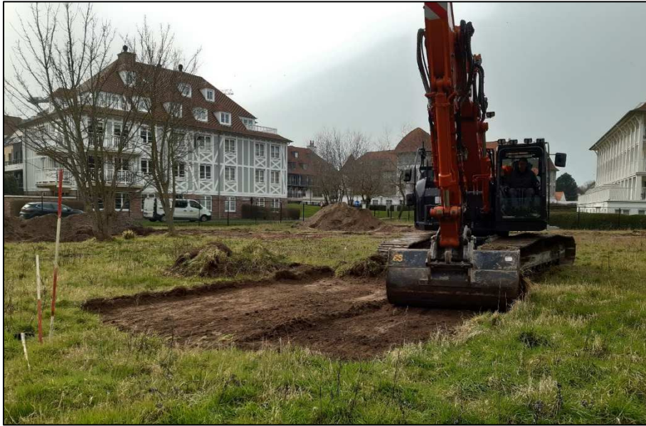
Figuur 16: Aanleg van een proefput – verwijderen bouwvoor.
