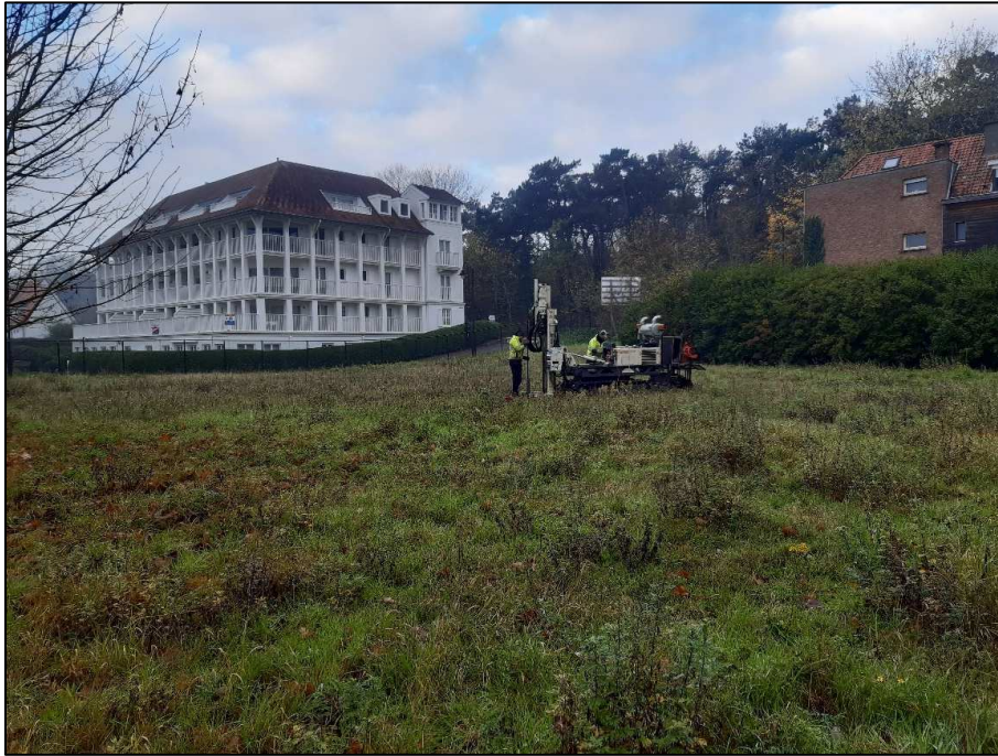
Figuur 5: Zicht op het plangebied ter hoogte van boring 4, gericht naar het noordwesten.
