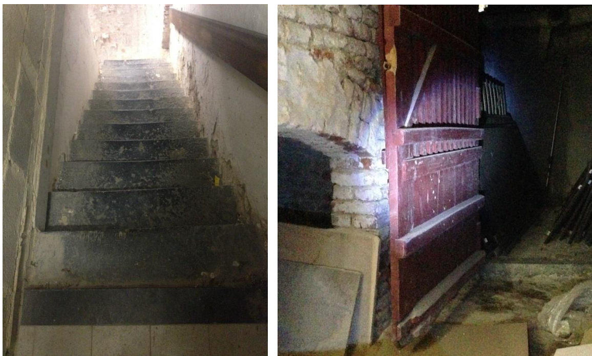
fig. 6: Links: Trap die uitgeeft op de keldergang. Rechts: Nis en opbergruimte onder de trap.
