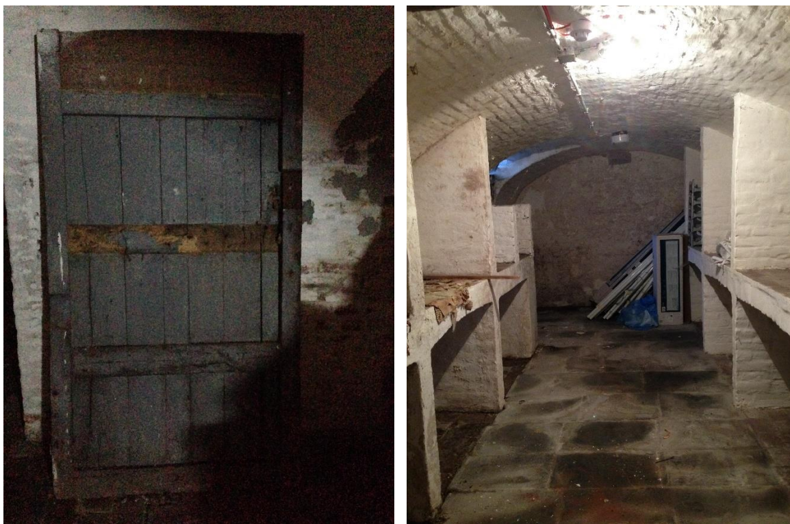
fig. 25: Kelderruimte E1. Links: oorspronkelijke kelderdeur. Rechts: kelder ingericht als opslagruimte.
