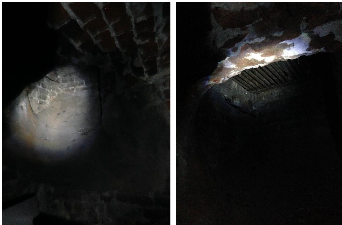
fig. 17: Kelderruimte B4. Kolengat in de noordoostelijke hoek van de ruimte.
