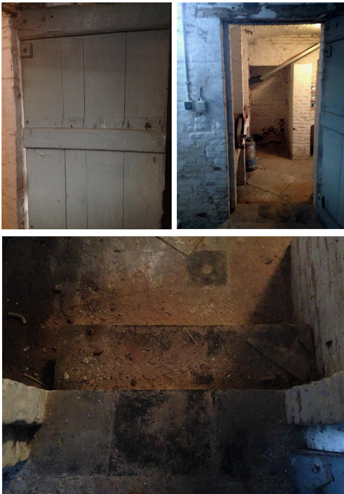
fig. 27: Kelderruimte E3. In klokwijzerszin: de kelderdeur; een blik door de open deur in kelderruimte; de deurdrempel.
