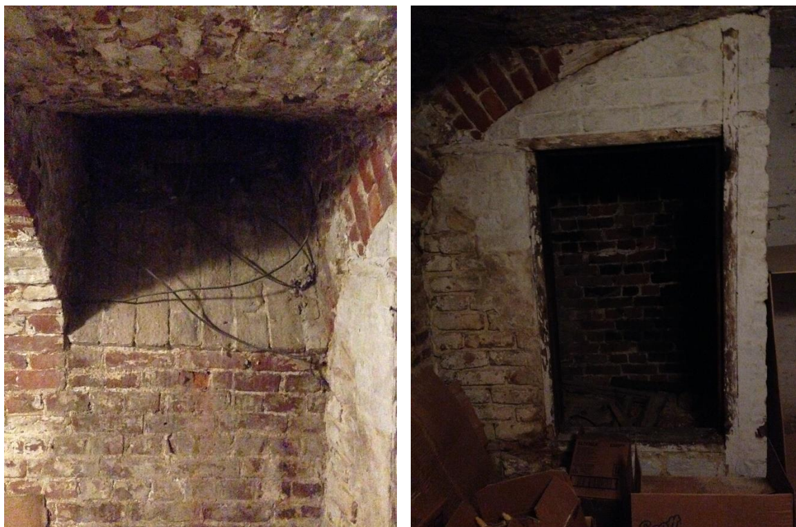
fig. 11: Kelderruimte B3. Links: steekkap. Rechts: opberghok in de noordwesthoek.
