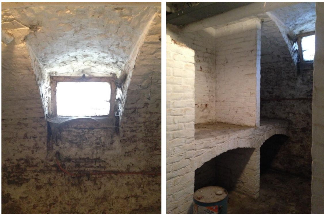
fig. 28: Kelderruimte E3. Links: kelderraam. Rechts: gemetselde opbergnissen.
