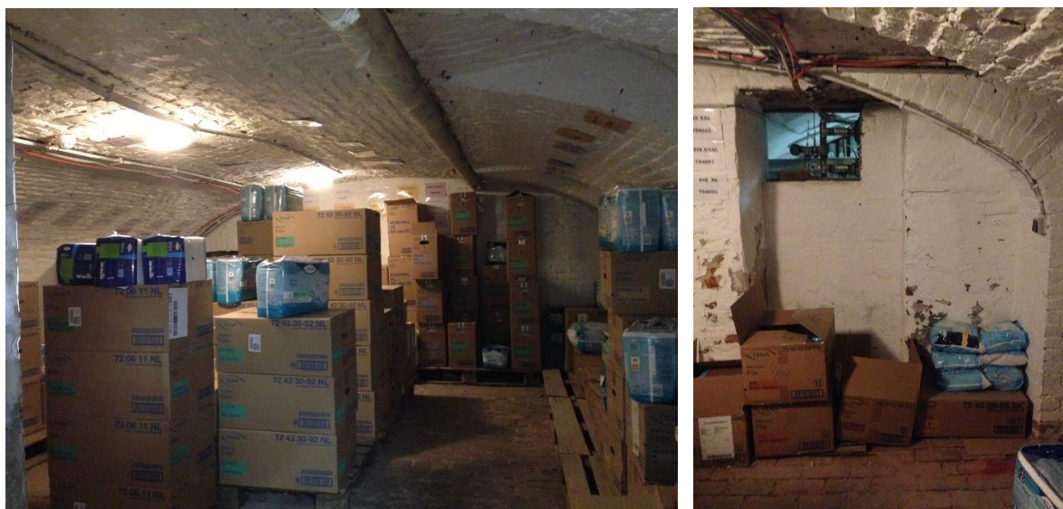
fig. 9: Kelderruimte B2. Rechts: de vroegere kelderopening tussen ruimte B2 en ruimte B5.
