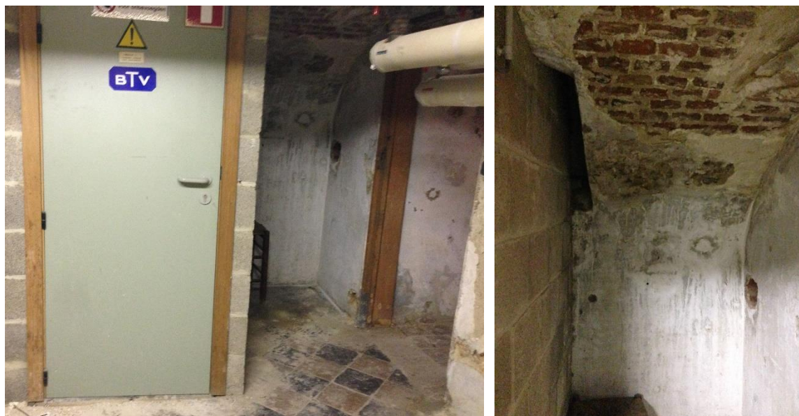
fig. 12: Kelderruimte B5. Links: ruimte met nutsvoorzieningen uit een latere bouwfase. Rechts: een oorspronkelijk steekkap die door de nieuwbouw oversneden werd.
