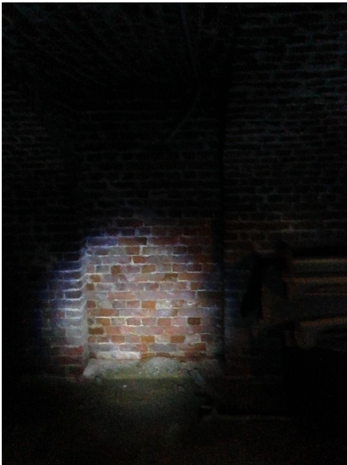
fig. 16: Kelderruimte B4. Dichtgemetselde doorgang naar een noordelijker gelegen kelderruimte.
