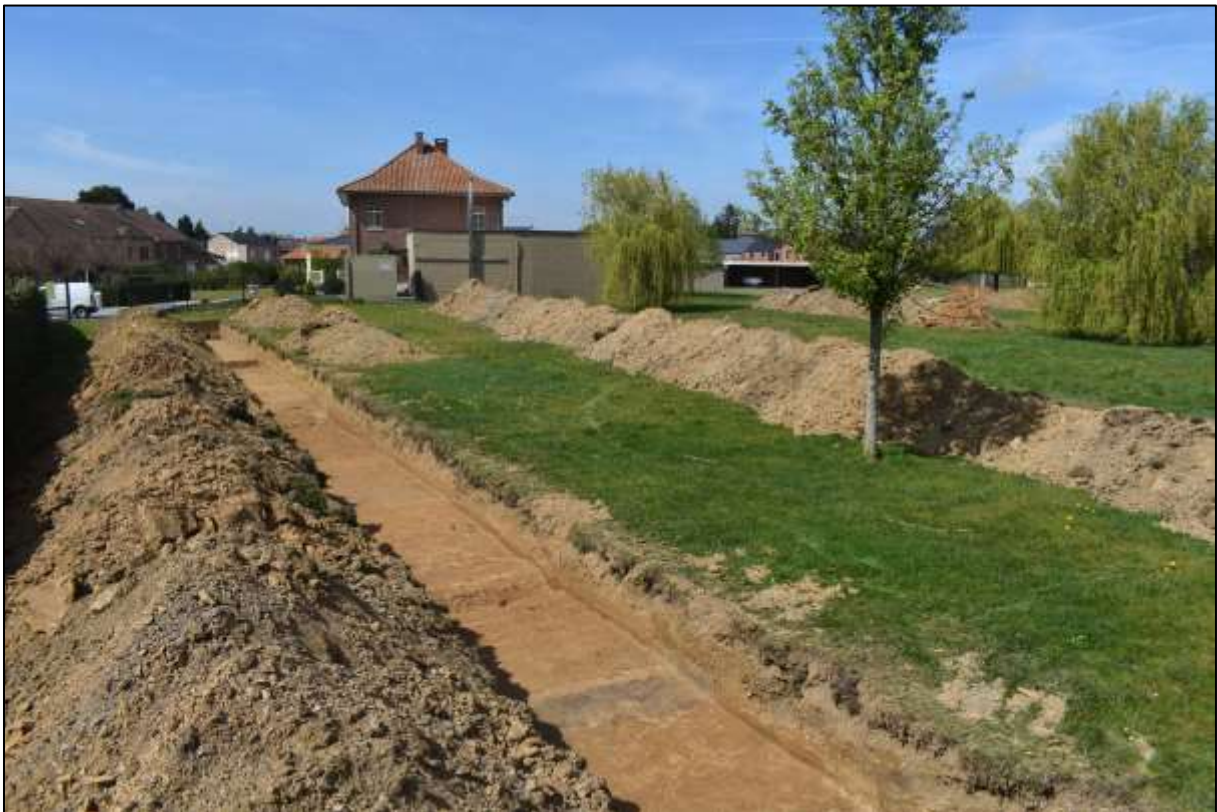
Afb. 20: Overzichtsfoto van aangelegde sleuven (Bron: ARON bv).
