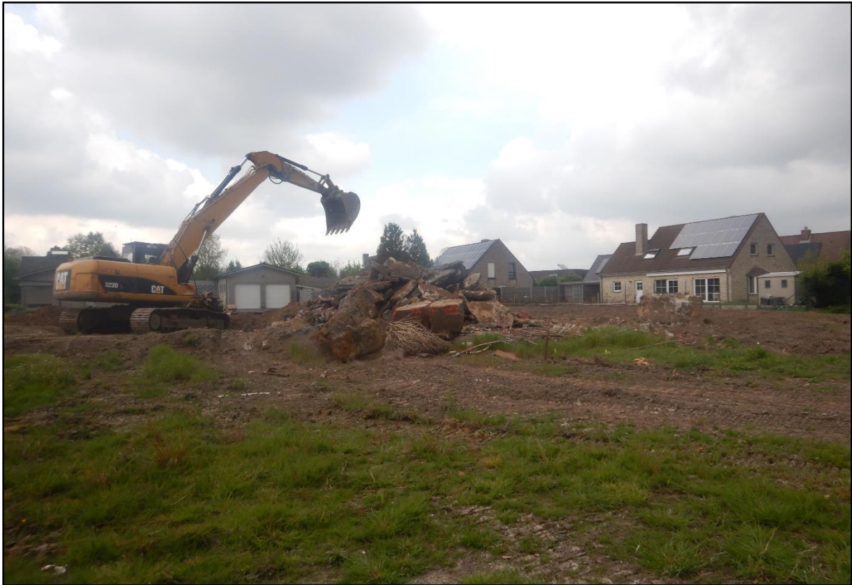
Figuur 2 Zicht op het noordoostelijke deel van het plangebied tijdens de sloop van de voormalige bebouwing.
