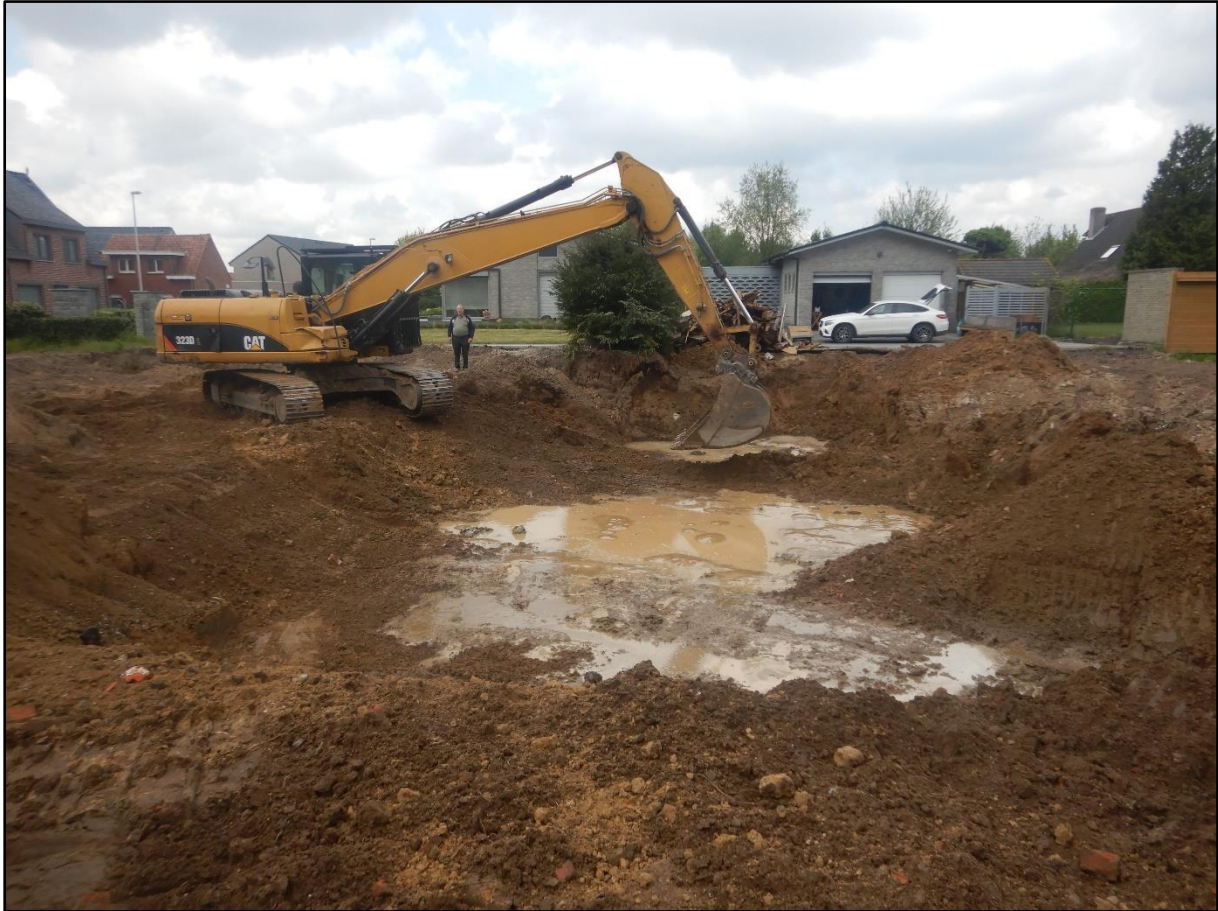
Figuur 4 Zicht op de uitgebroken kelder en kruipkelder ter hoogte van Snekpestraat 56.
