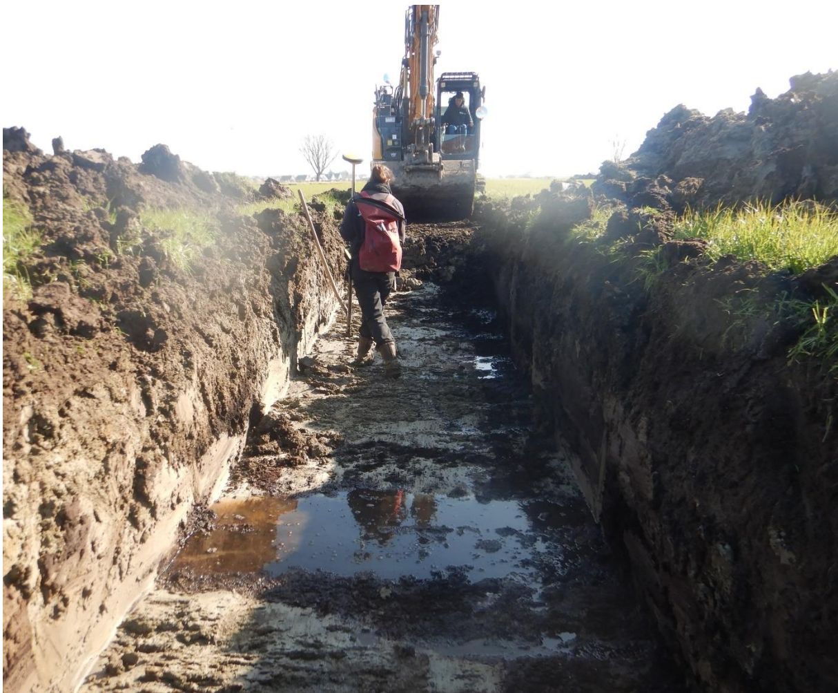
Figuur 7: Sfeerbeeld tijdens de aanleg van proefsleuf 3.
