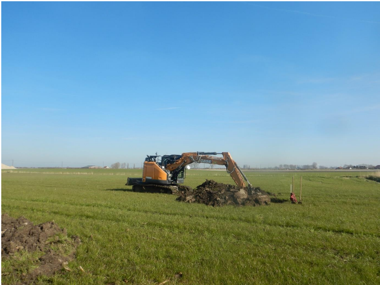
Figuur 8: Het uitgraven van sleuf 3.
