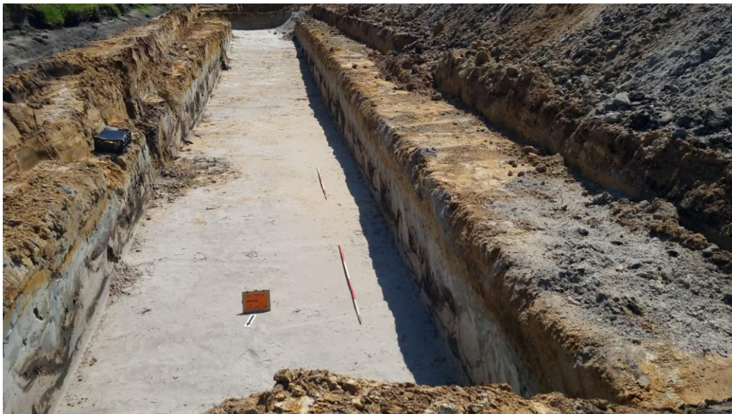
Afb. 11 De getrapte aanlegmethode in werkput 1.
