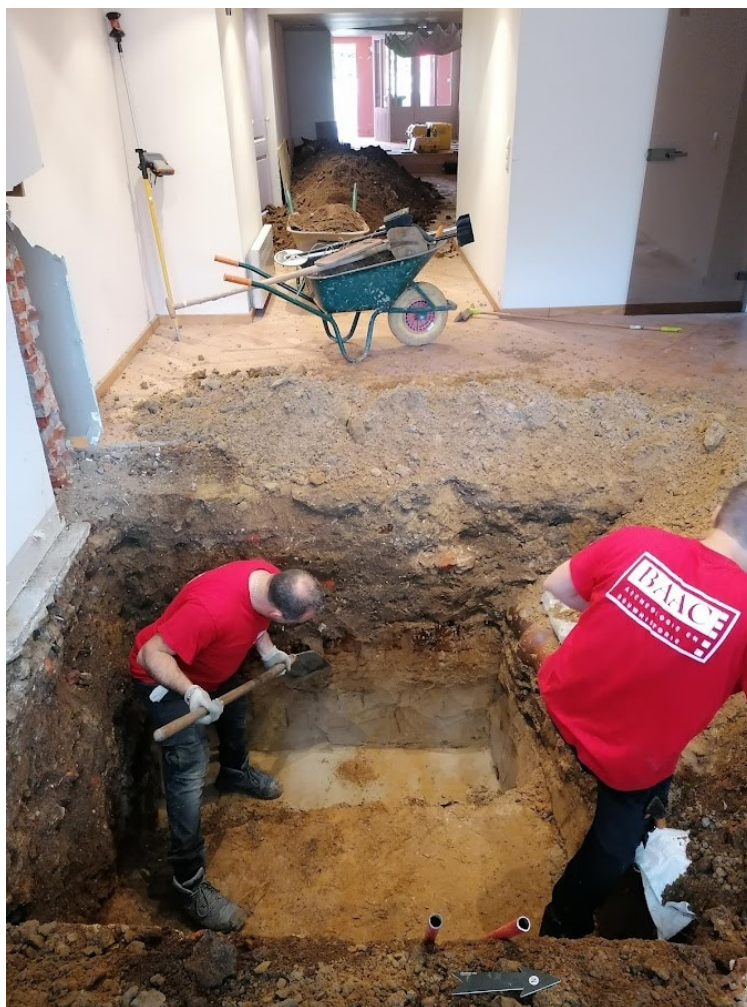
Figuur 2: Manueel uitgraven van werkput 1 binnenin het pand.
