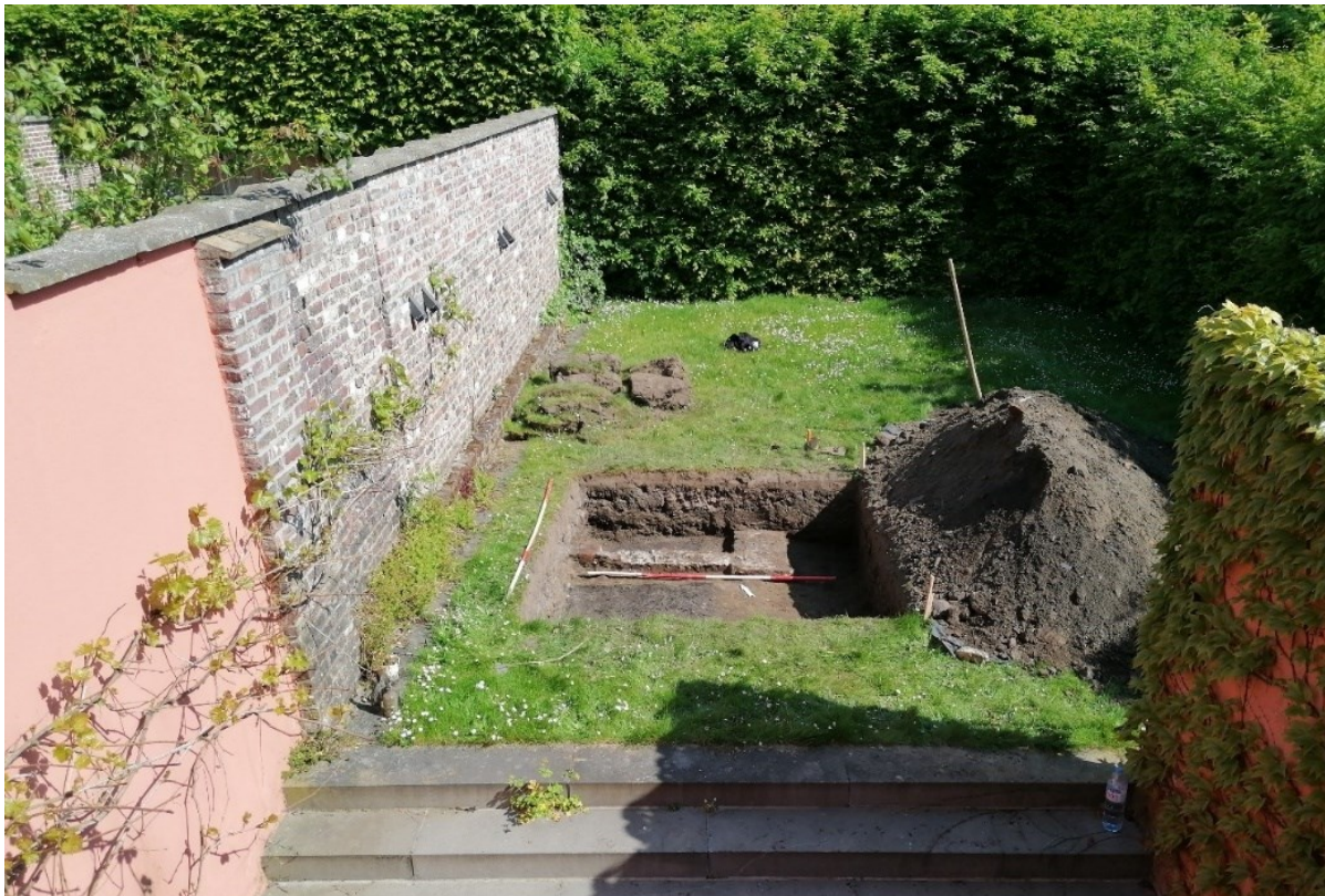
Figuur 3: Zicht op werkput 2 in de tuin.
