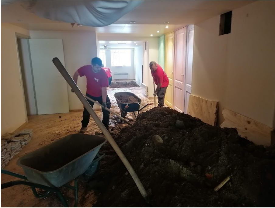
Figuur 5: Manueel dichten van werkput 1 in het pand.
