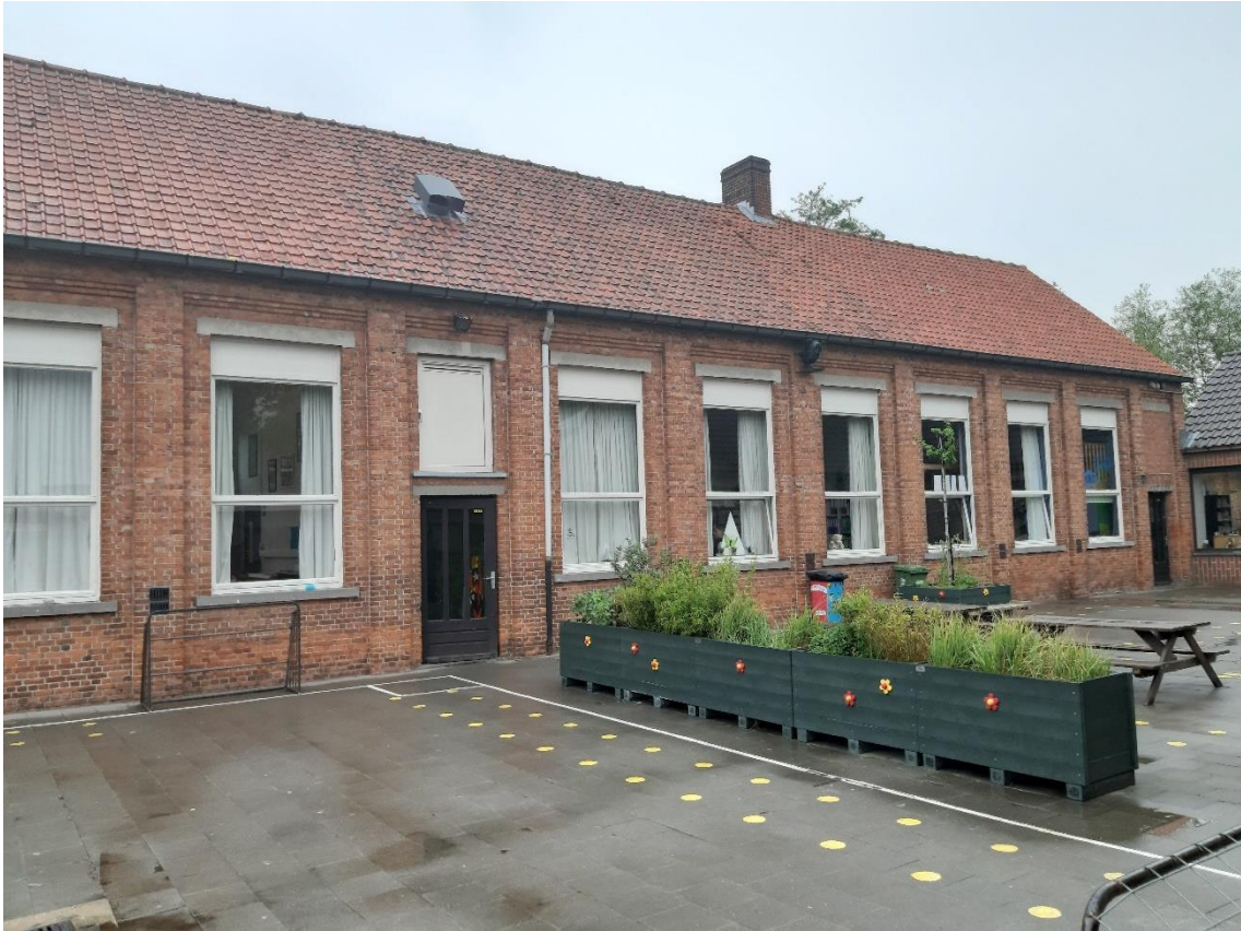
Figuur 7: Te slopen bebouwing gezien vanuit het binnengebied (gebouw B)
