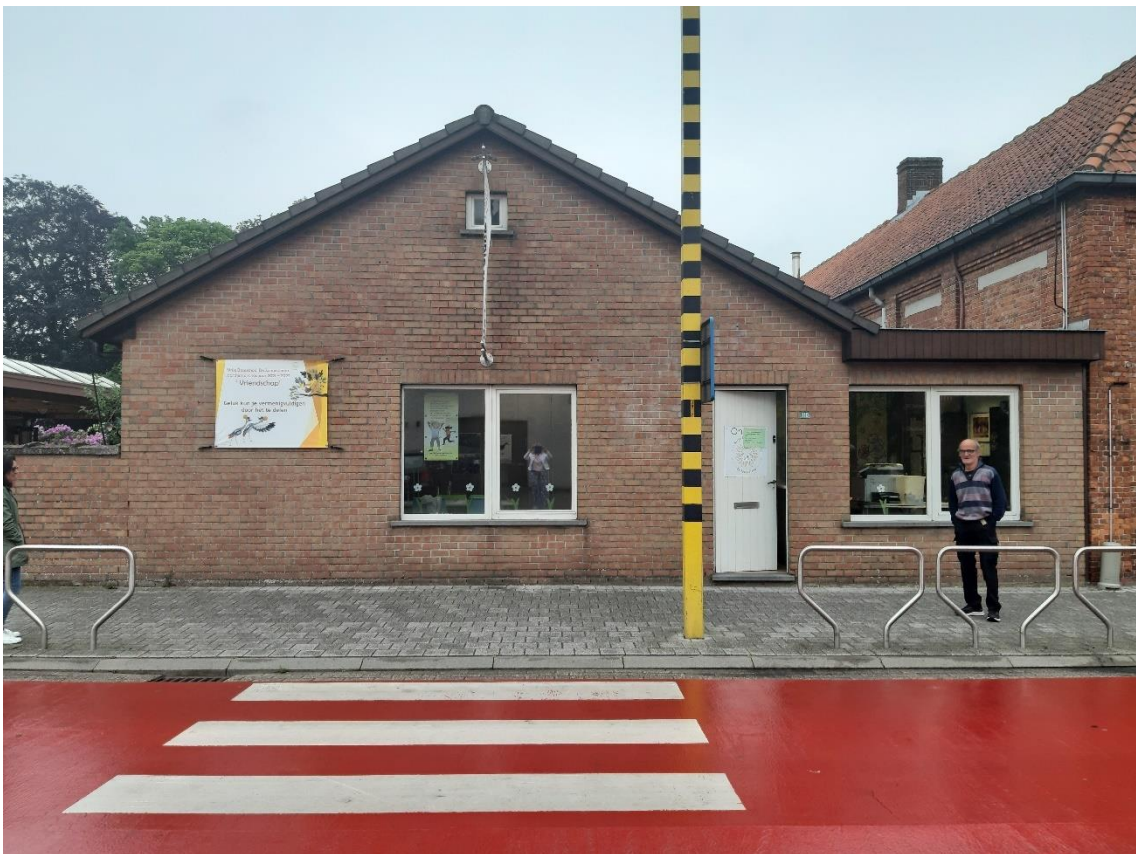
Figuur 8: Te slopen bebouwing gezien vanaf Koewacht (gebouw F)
