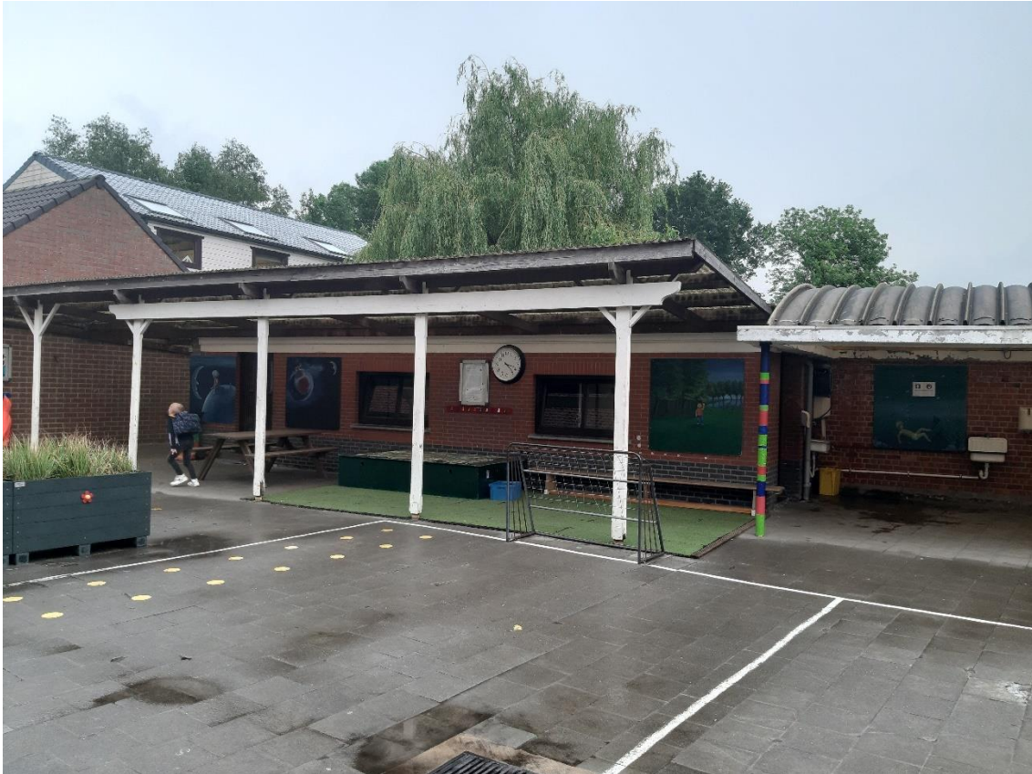
Figuur 9: Te slopen bebouwing gezien vanuit het binnengebied (gebouw H)
