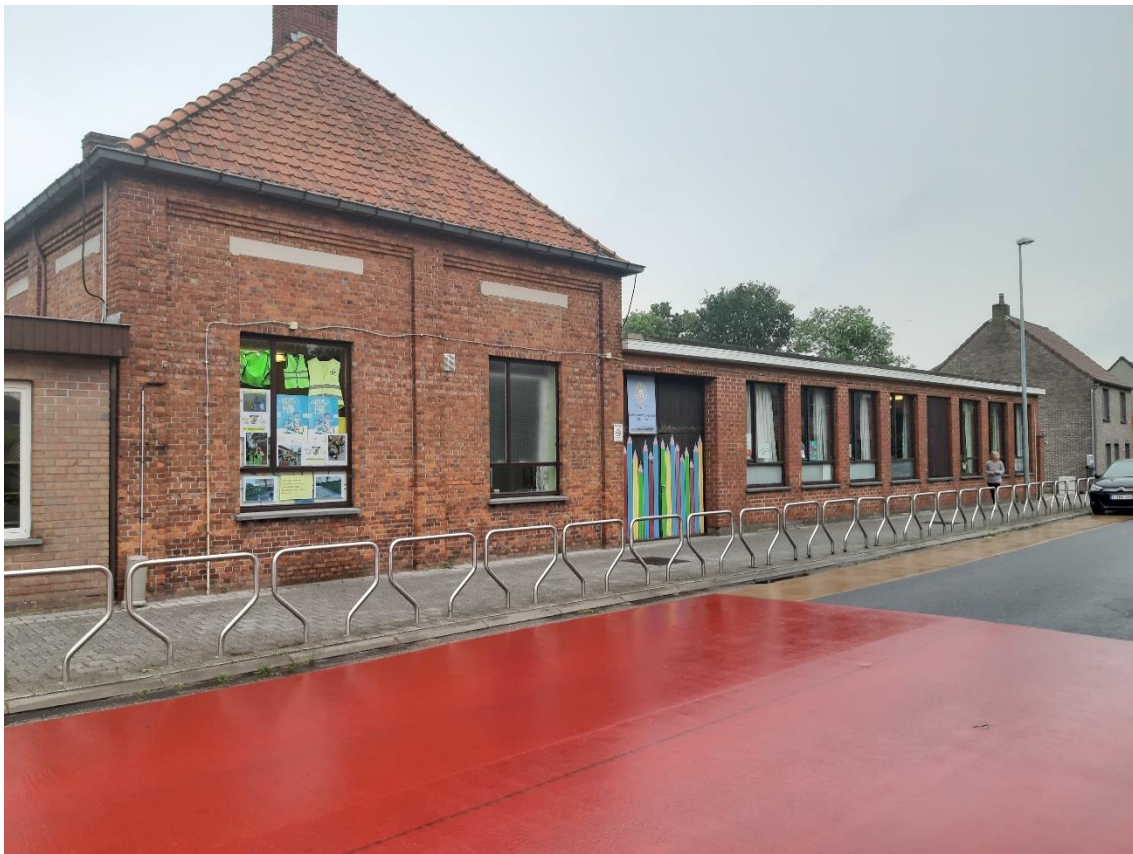
Figuur 4: Te slopen bebouwing gezien vanaf Koewacht (gebouwen B (links) en A (rechts))
