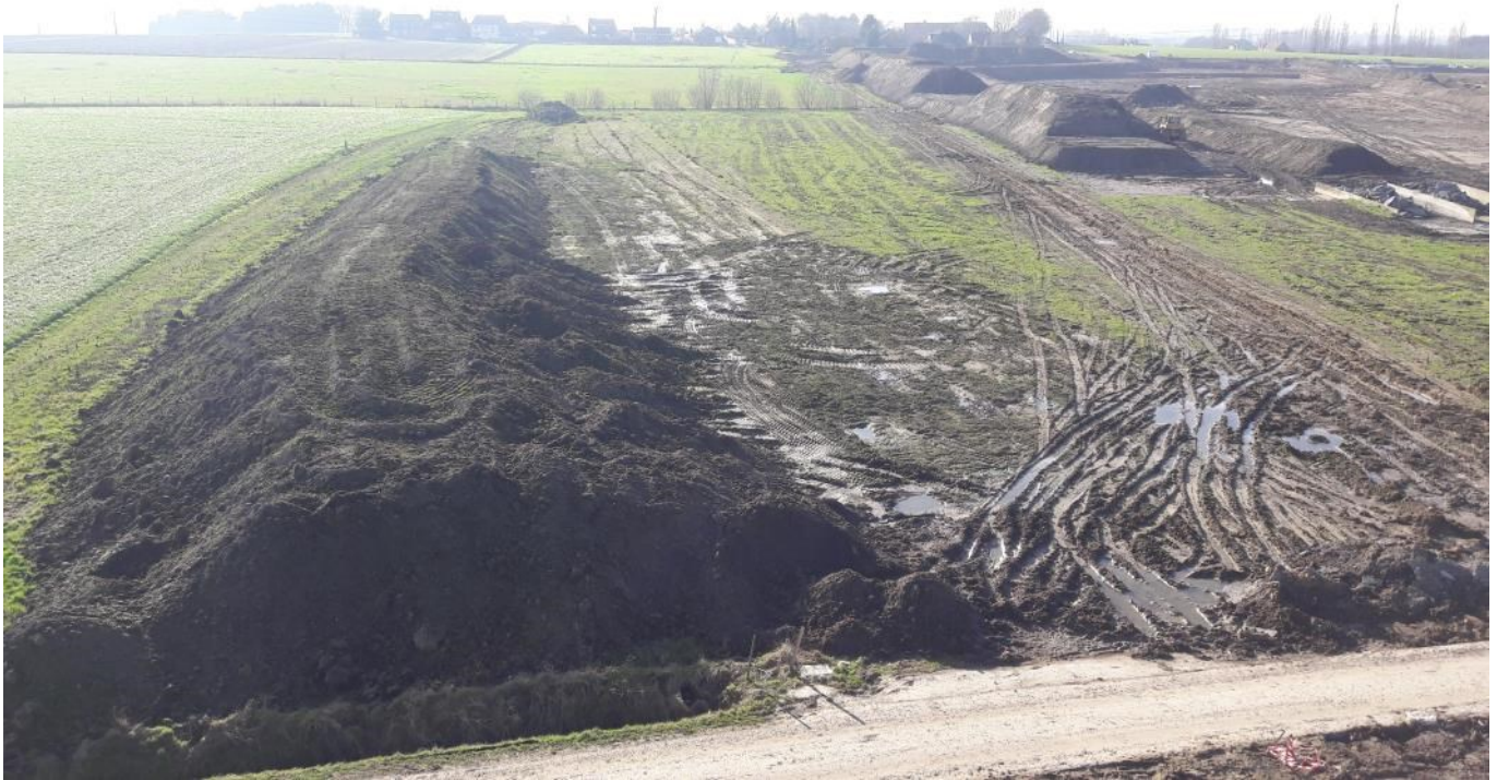
Figuur 1: Uitzicht op het terrein met de trapeziumvormige berg teelaarde.
