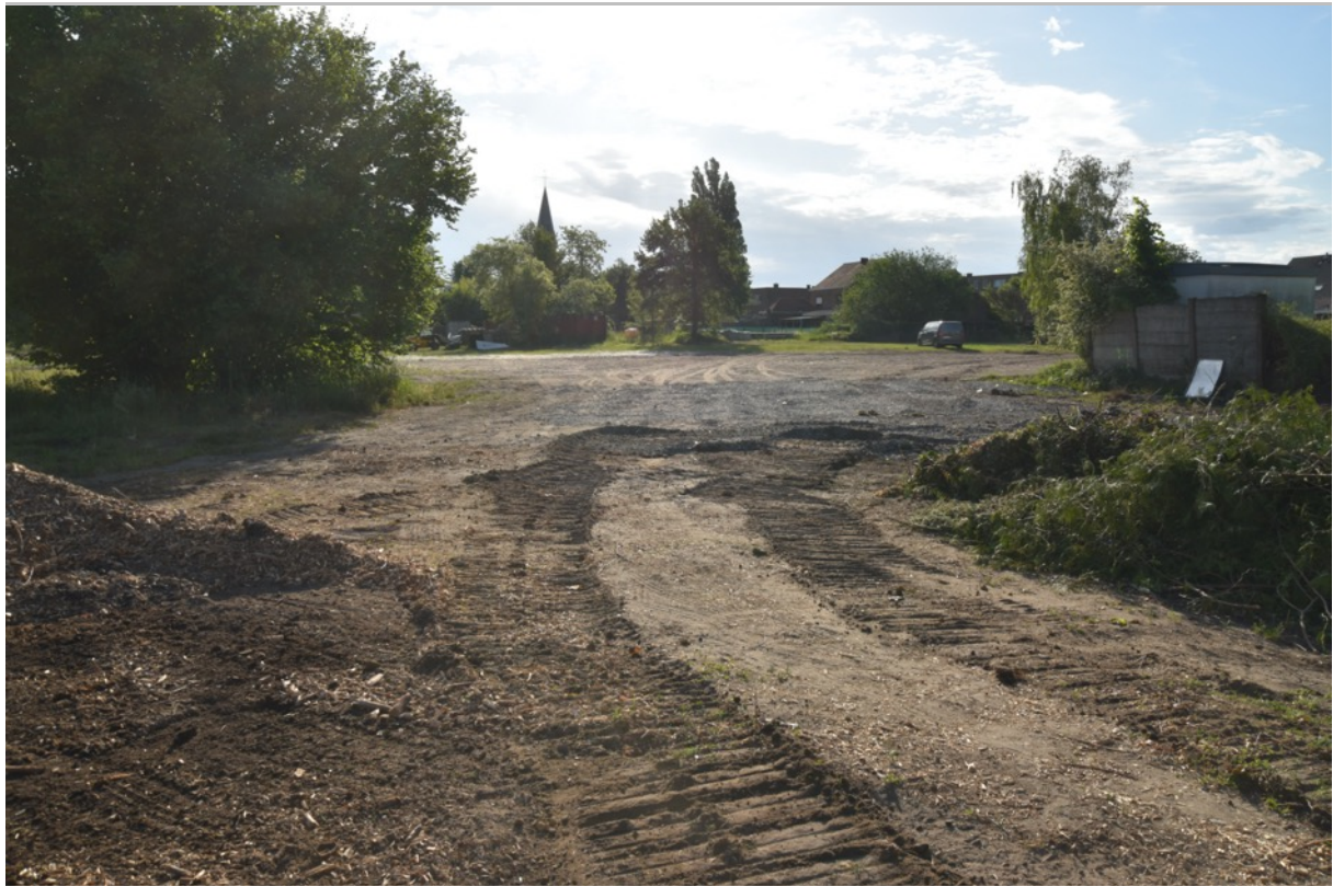
Fig. 3.18: Zone achter de zuidwestelijke parking, in gebruik als braakliggend terrein met storthoop
