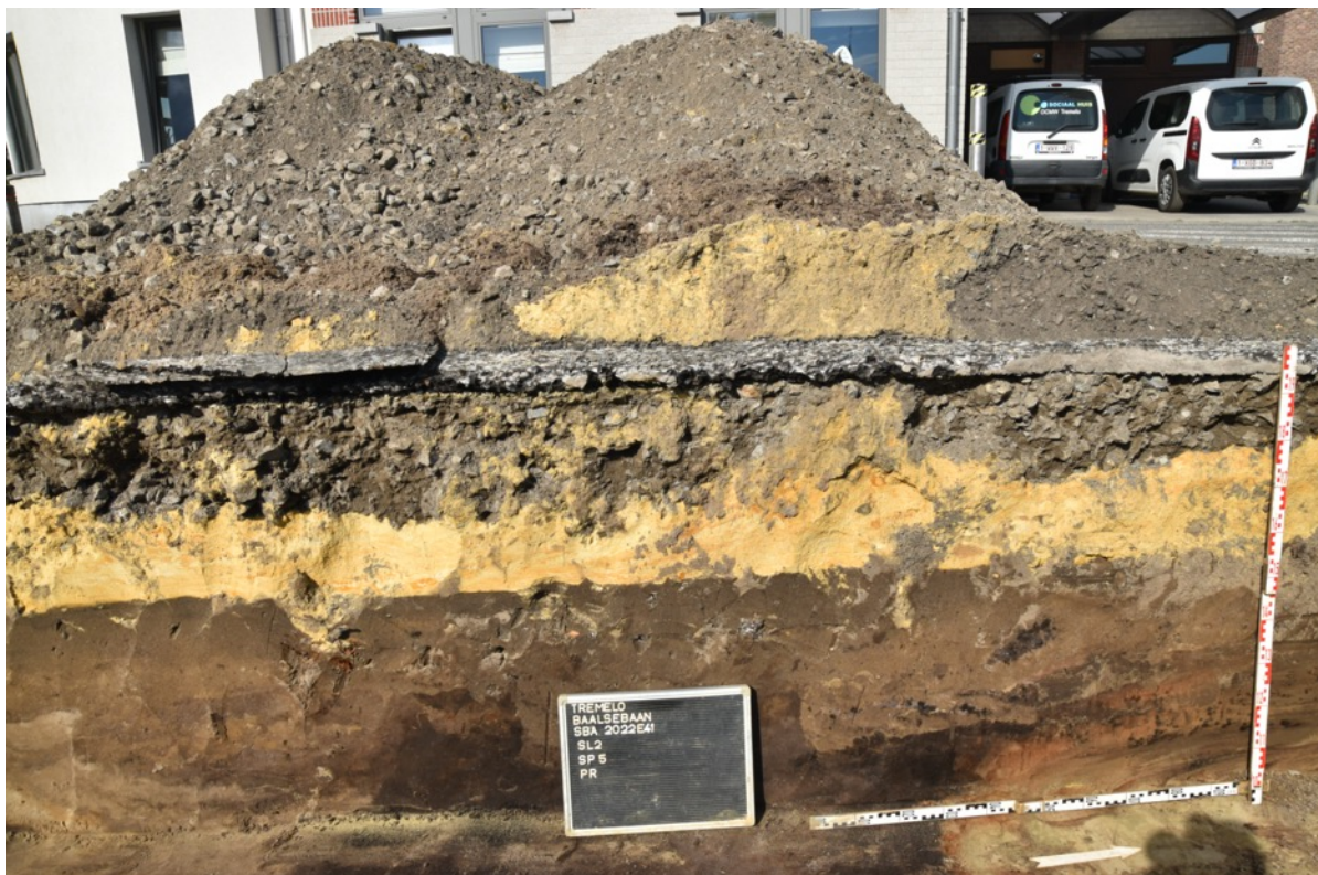
Fig. 3.20: Foto met zicht op de funderingslaag die zich onder het asfalt van de parking bevond in sleuf
