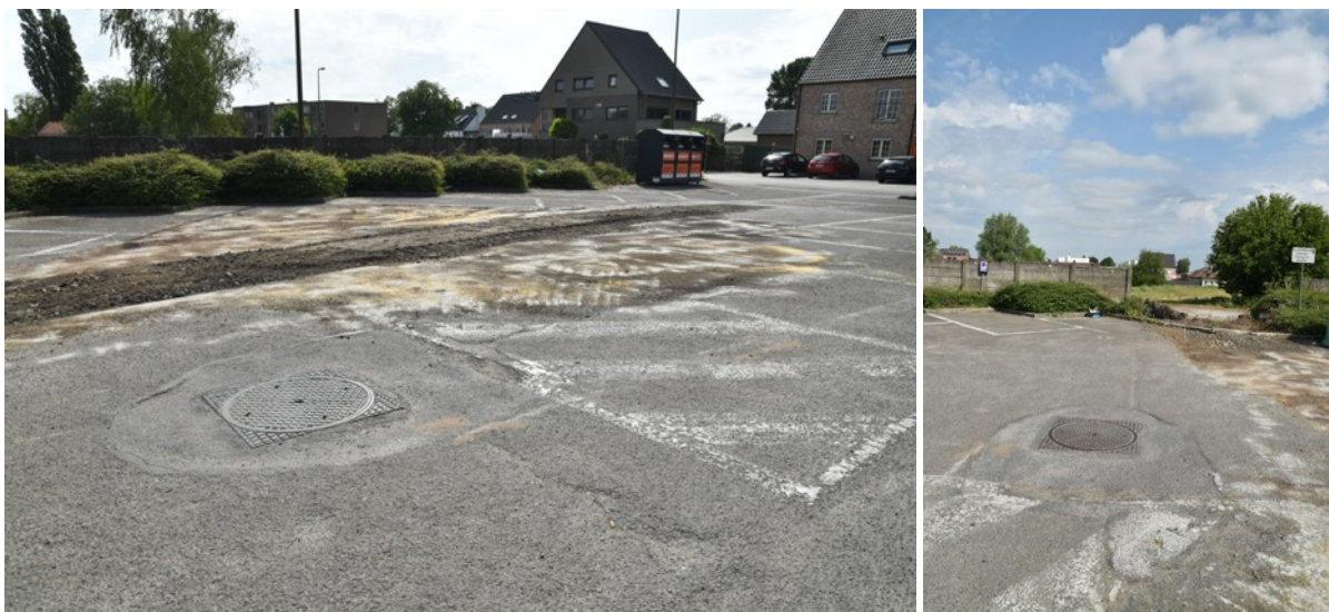
Fig. 0.7: Overzichtsfoto's van de verhardingen en mangaten op de parking in het zuidwesten van het terrein.
