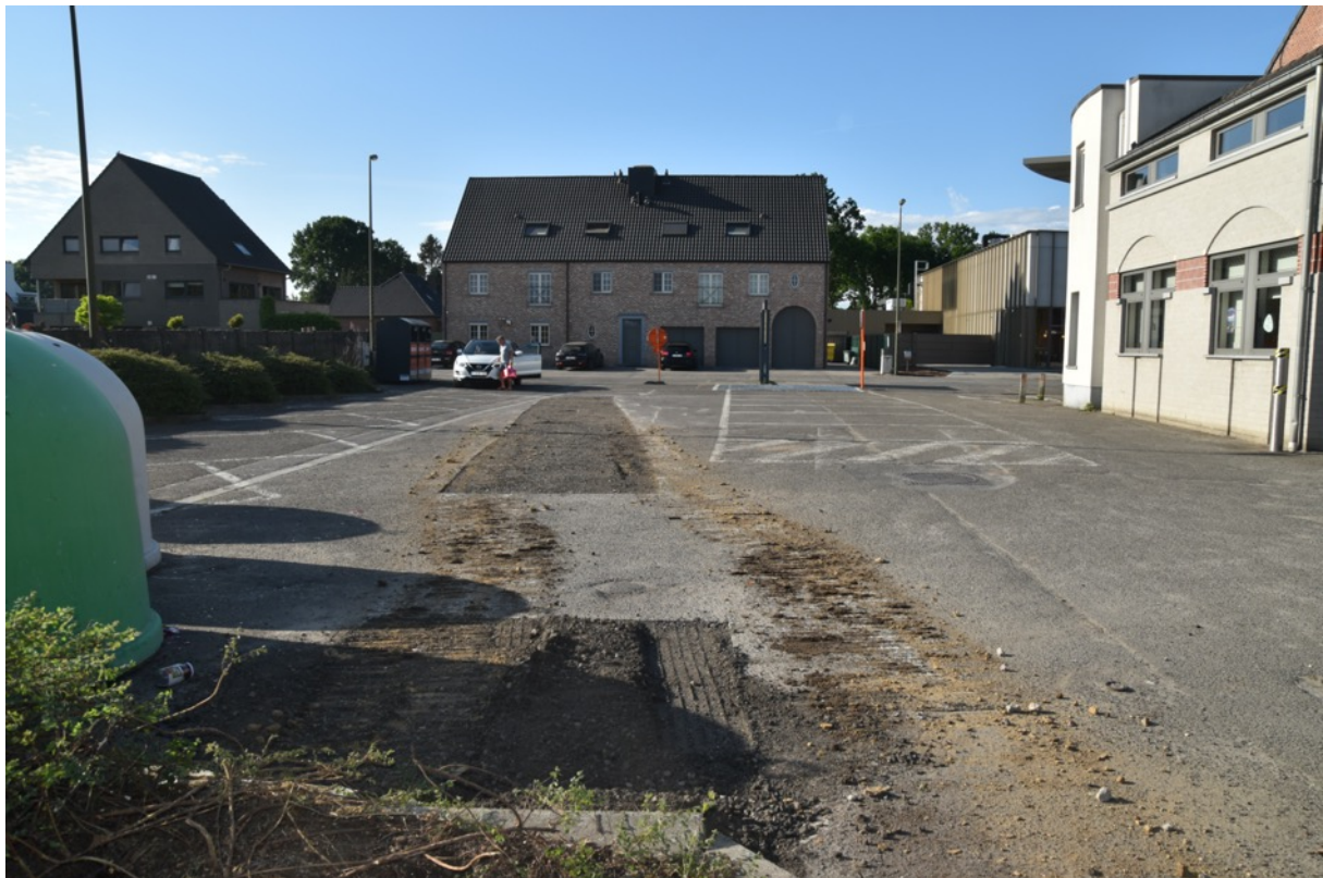
Fig. 3.15: Overzichtsfoto van de zuidwestelijke parking.
