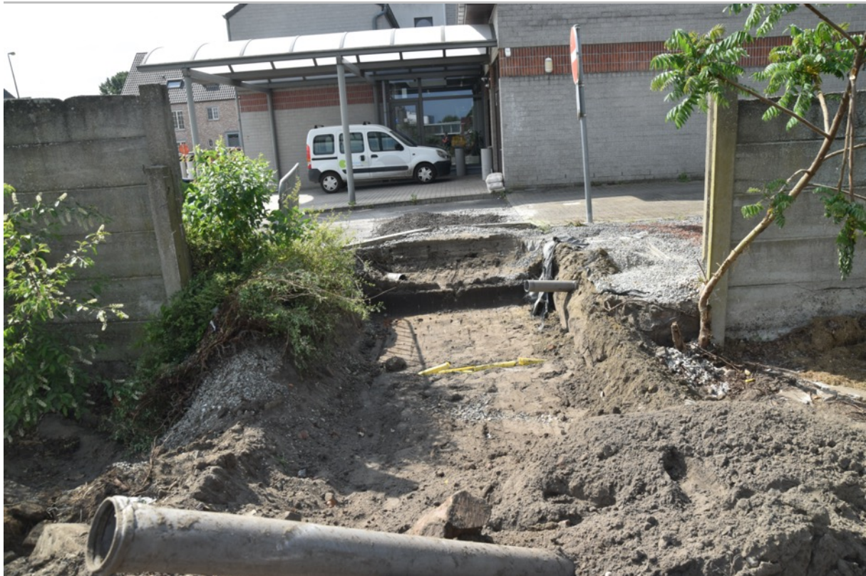
Fig. 3.9: Overzichtsfoto van de leidingen die beletten om sleuf 1 aan te leggen tot op de verharde parking in het zuidwesten van het terrein
