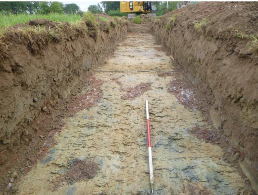
Afb. 17. Het aanleggen van werkput 1: ongeveer in het midden van de sleuf, waar de recente verstoring minder diep wordt, maar nog wel verspreide vlekken achterlaat in het vlak.
