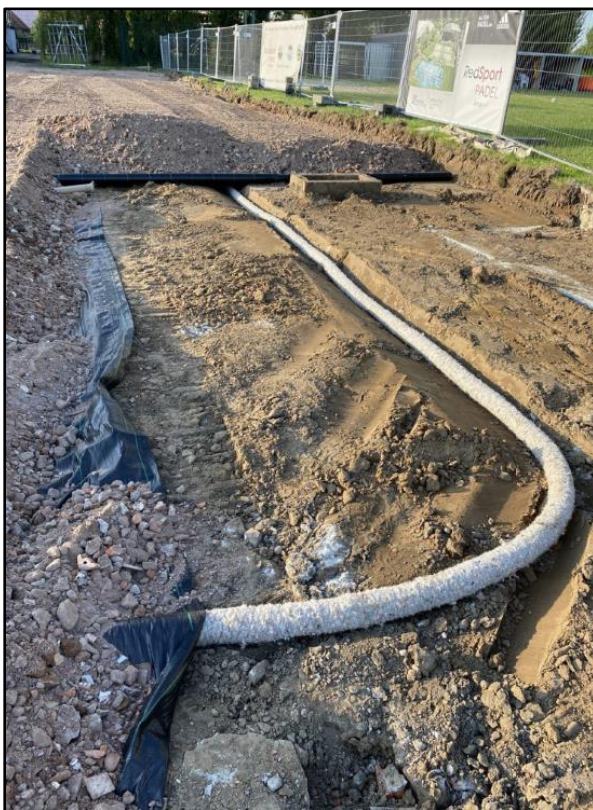
Figuur 5 Drainagesysteem afgedekt met worteldoek en 30cm dik steenslagpakket.
