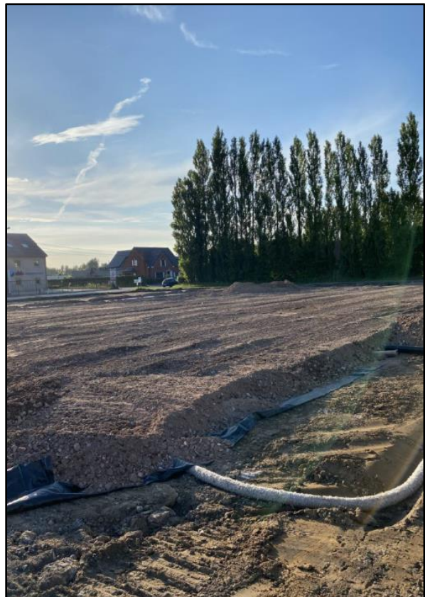
Figuur 5 Drainagesysteem afgedekt met worteldoek en 30cm dik steenslagpakket.
