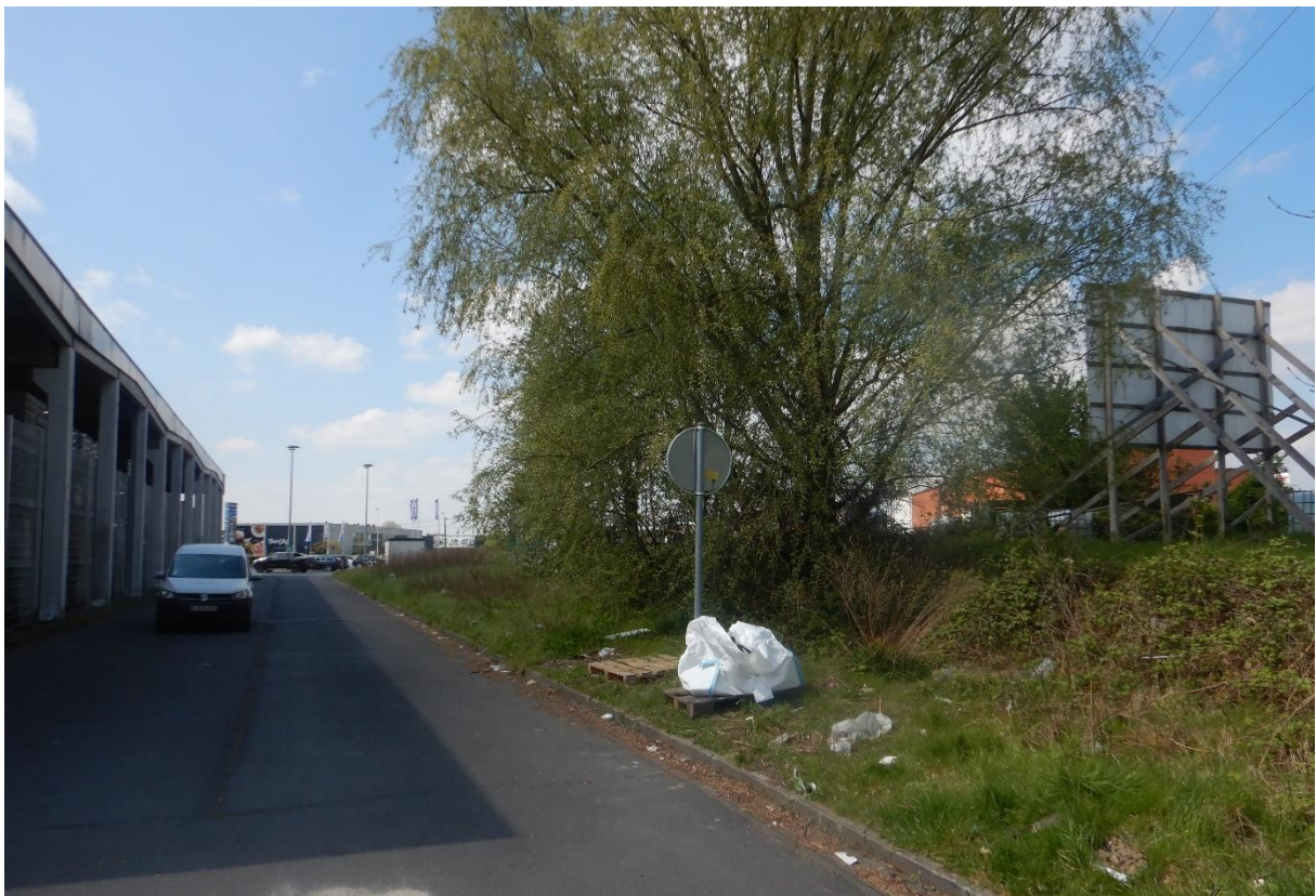
Figuur 8: Zicht op het aanwezige talud dat grenst aan de Brugsesteenweg, met de aanwezige beplanting en in de verte de elektriciteitscabine.
