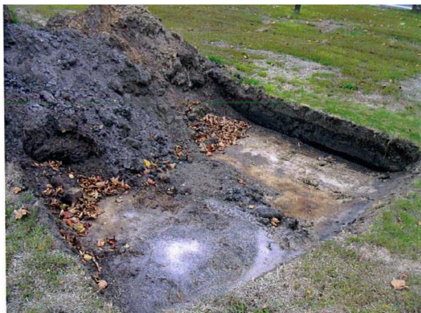
Figuur 20: Afbeelding van ontgraving voor sanering. 26
