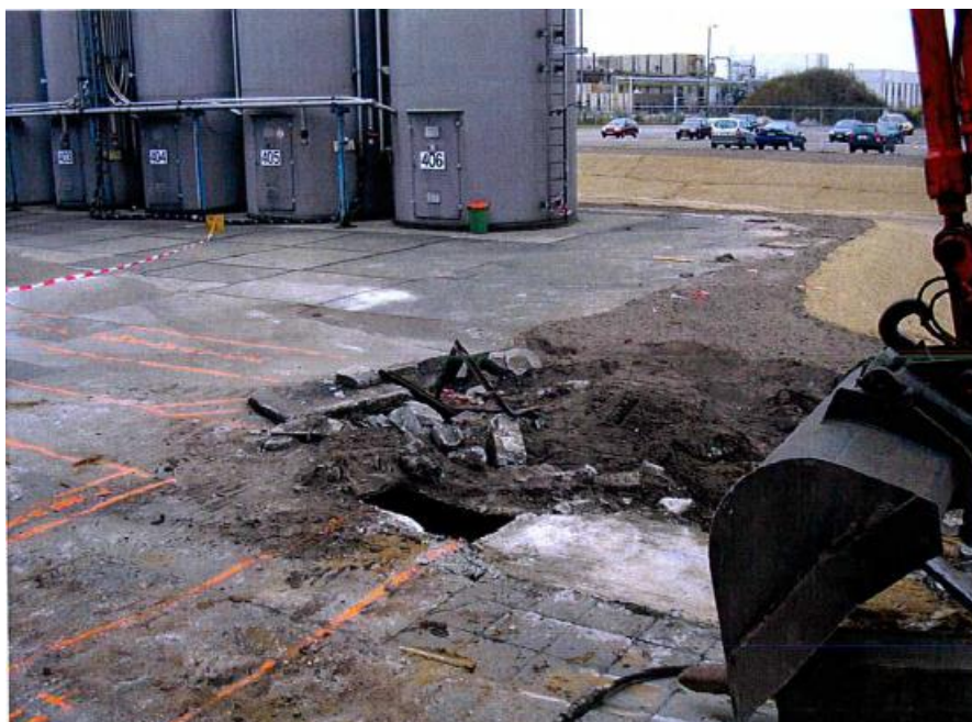
Figuur 21: Afbeelding van ontgraven zone ter hoogte van de huidige vijver. Hier waren er veel ondergrondse nutsvoorzieningen aanwezig.. 27
