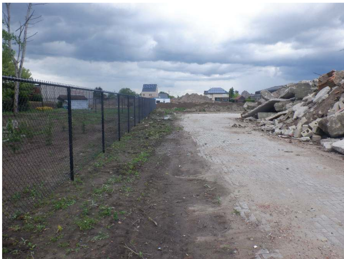
Afbeelding 3.6.6: Plangebied ter hoogte van boring 6 in noordelijke richting.
