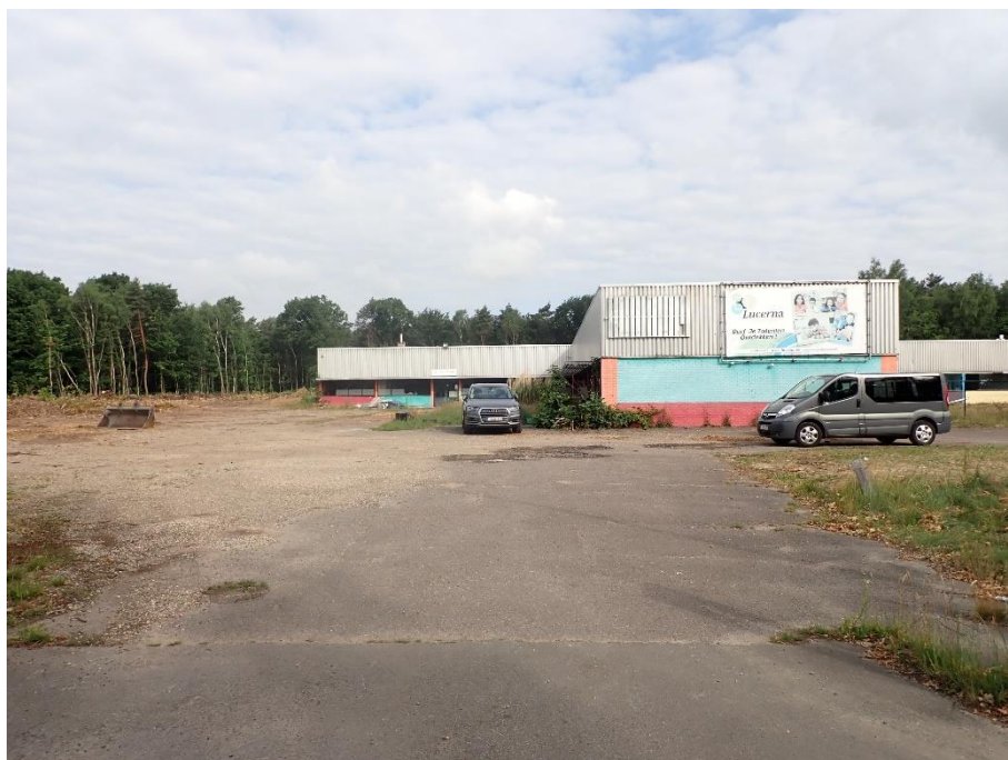
Figuur 18: Zicht op werkput 1 – kijkrichting zuidoost © J. Verrijckt Bvba
