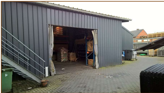
Foto 11: Zicht op overdekt magazijn in de opslagzone.
