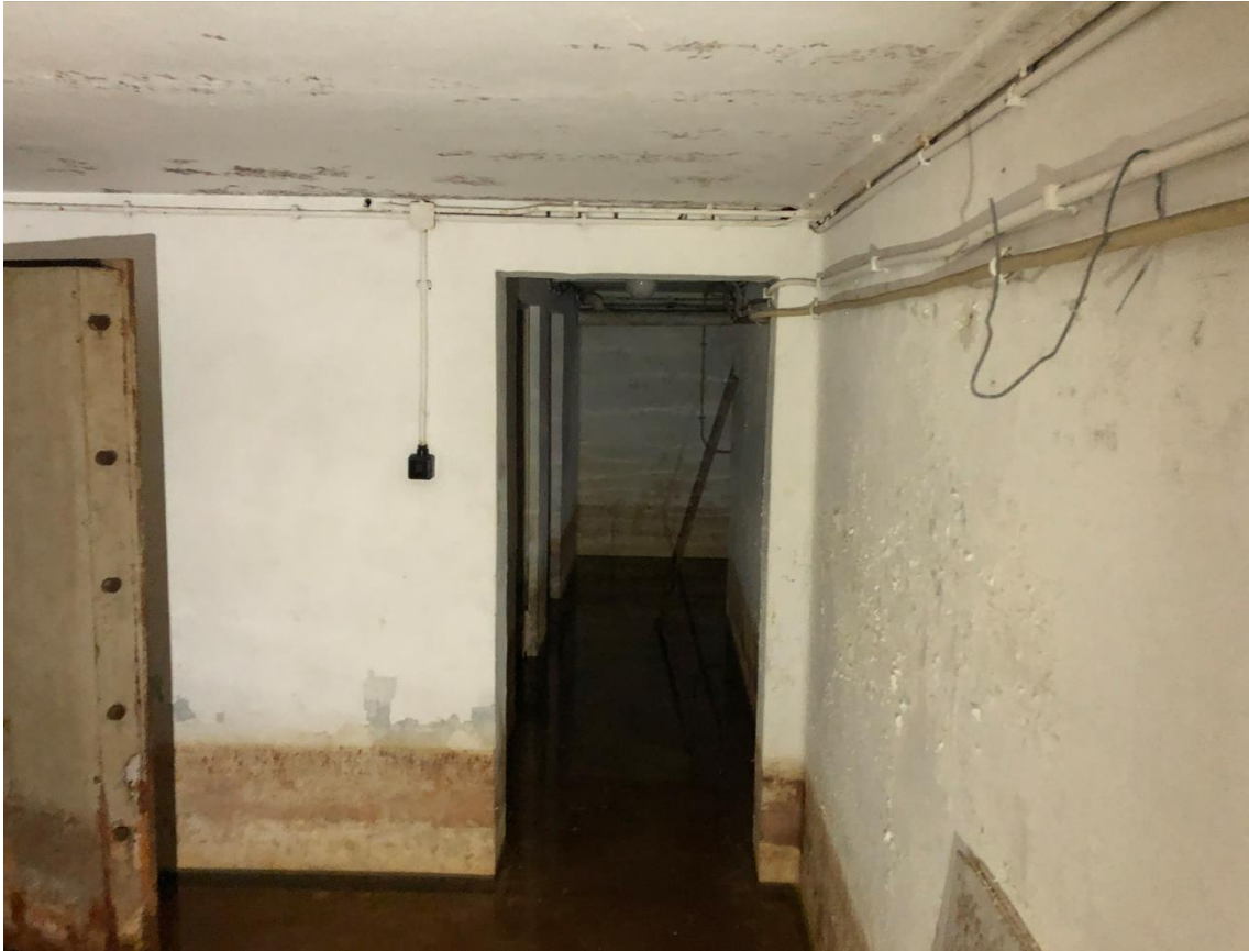
Figuur 6: Kelder onder te slopen zuidelijke gebouw
