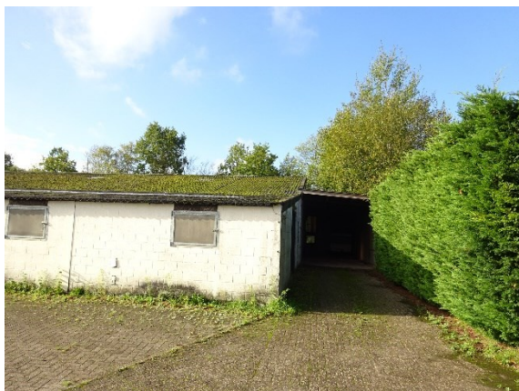
Foto 3: uiterst westelijke gedeelte van de bestaande bebouwing met verharding (bron: ABO nv, 18/10/2019)
