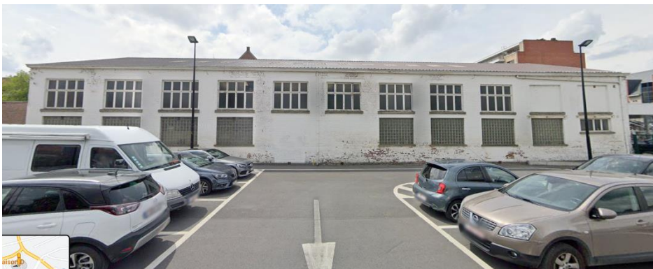
Figuur 6: Huidige toestand met hangar/bedrijfsgebouw vanaf de parking in het oosten (Google Street View, 2019)
